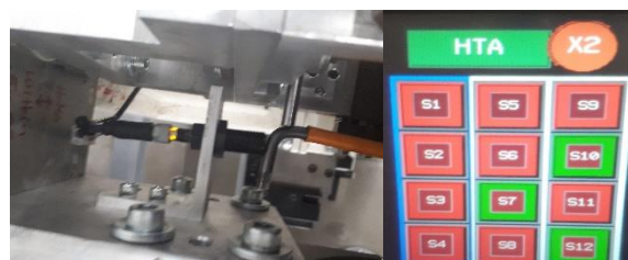
Fig. 69 Verificación de señal de sensor inductivo
