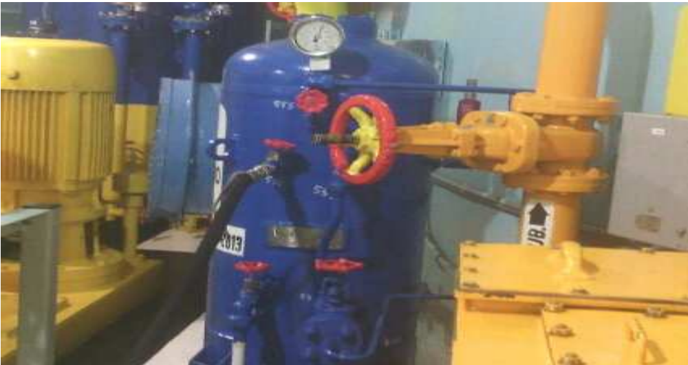
Figura 22. Conexión de la manguera temporal al tanque intermedio.
