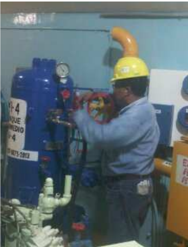
Figura 20. Maniobras de montaje para la conexión temporal.
