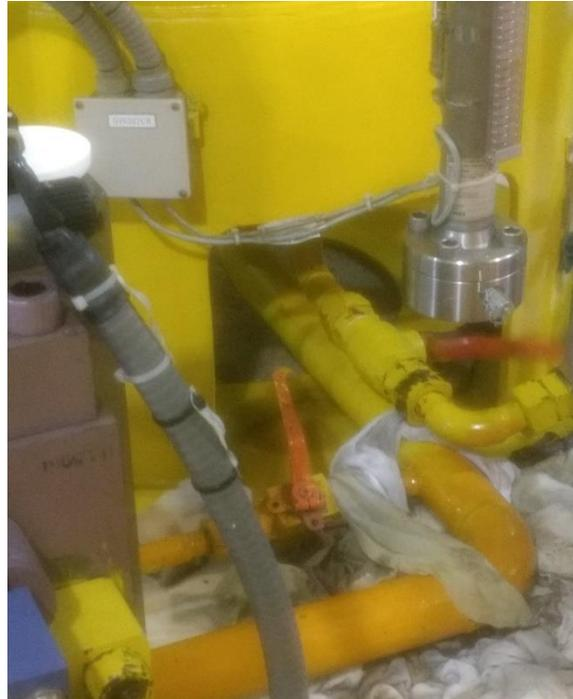
*Figura 34.- Fuga en el tanque acumulador*
