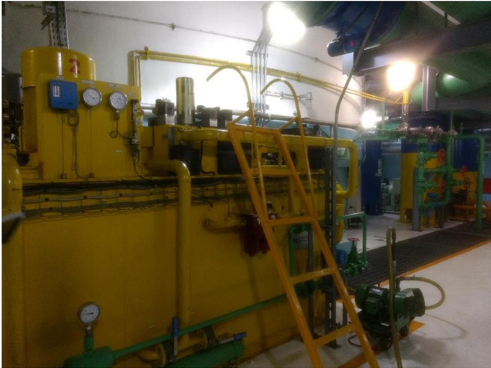
*Figura 33.- Contenedor de aceite del sistema de regulación*
