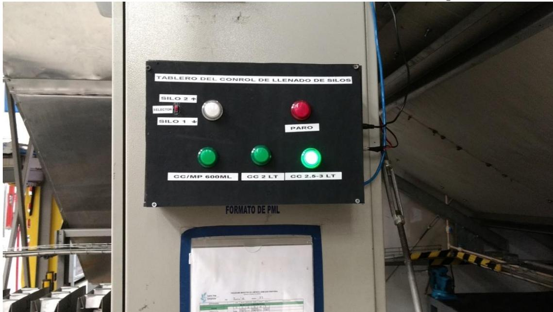
Figura 41 Tablero del control de llenado de silos.
