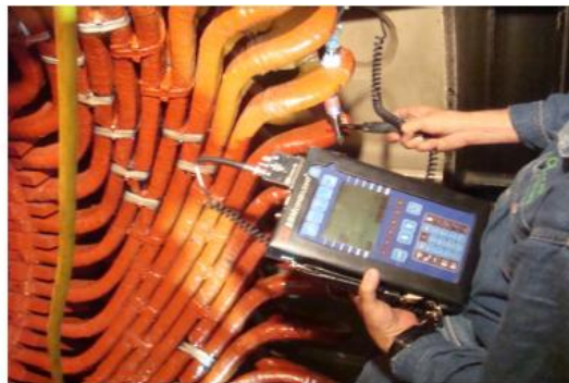
Figura 10 Prueba de impacto en zona de cabezales
