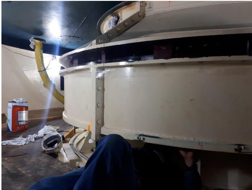
Figura 37 Montaje de la cuba y depósito de la chumacera de carga
