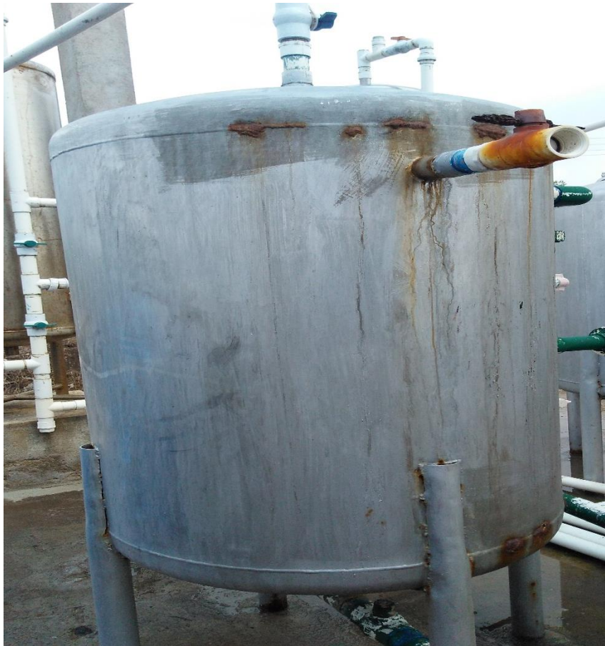
Figura 39. Filtro de carbón activado.
