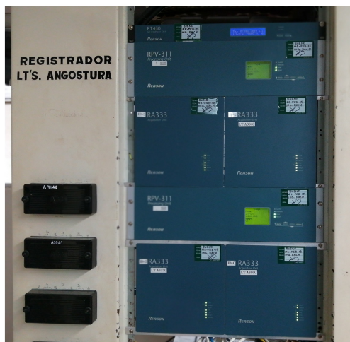
Figura 3.3: Registrador de fallas REASON
