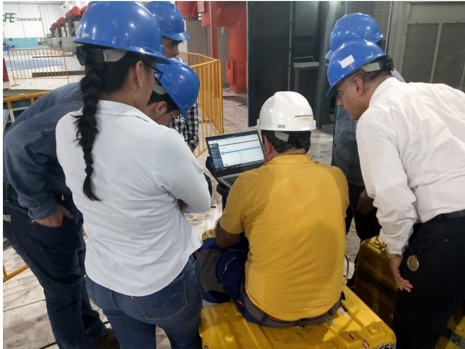
Figura 6. Prueba de equipo OMICRON a transformador de potencia (Cumplimiento de Calidad)
