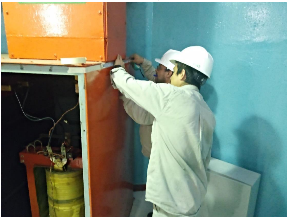
Figura 7. Instalación de relevador de falla a tierra del Generador N°2, técnicos dando seguimiento a orden de trabajo y seguridad ante todo.
