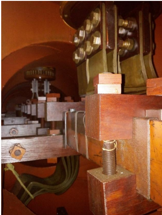
Fig. 4. 14 Interconexión de Transformadores monofásicos en Delta.
