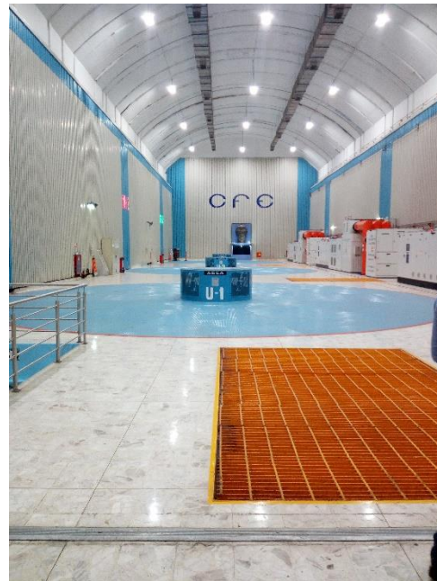
Fig. 3. 1 Casa de máquinas
