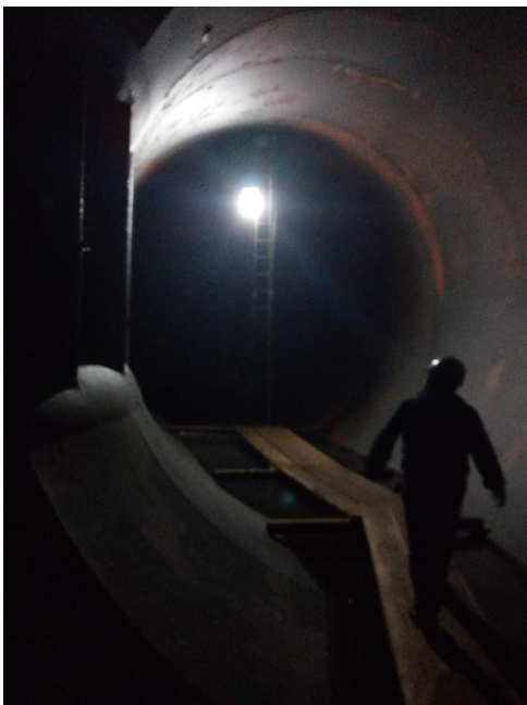
Fig. 3. 2 Caracol, llamado así por la terminación en los alabes móviles
