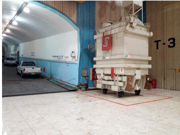
Fig. 3. 3 Playa de montaje, se puede apreciar un transformador monofásico auxiliar
