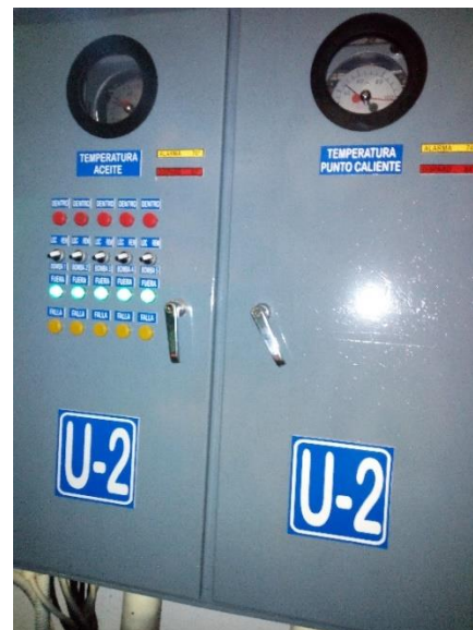
Fig. 4. 5 Gabinete después del mantenimiento
