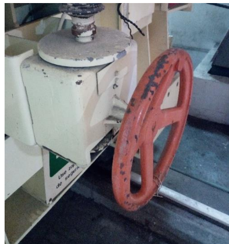
Fig. 4. 10 Cambiador de derivaciones en posición 2
