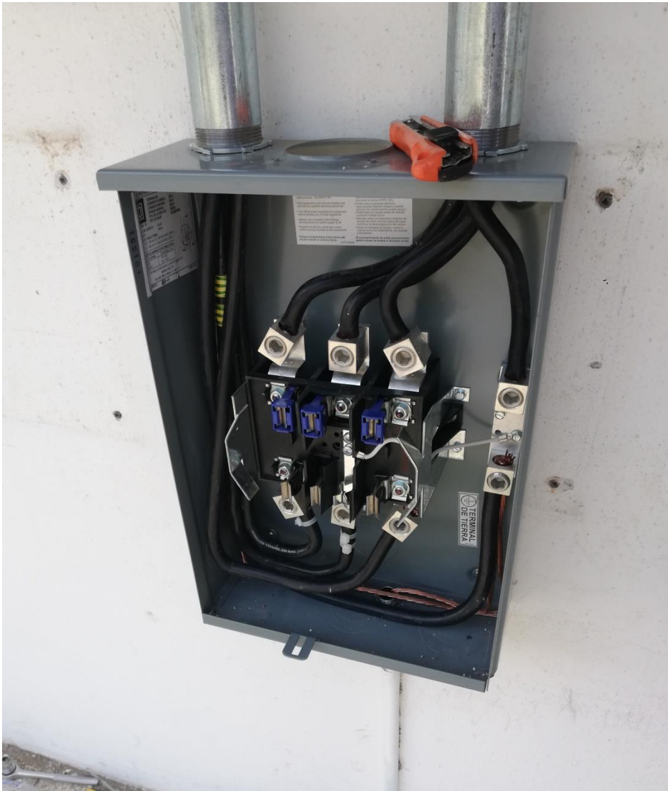
Ilustración 29 Base de medidor bidireccional
