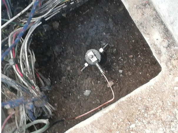
Ilustración 27 Protección tierra física e ITM ajustable
