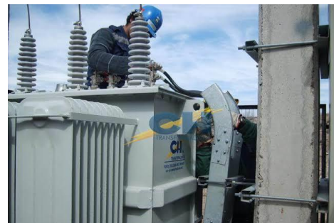
figura 6. pruebas de puesta en servicio de un transformador de distribución
