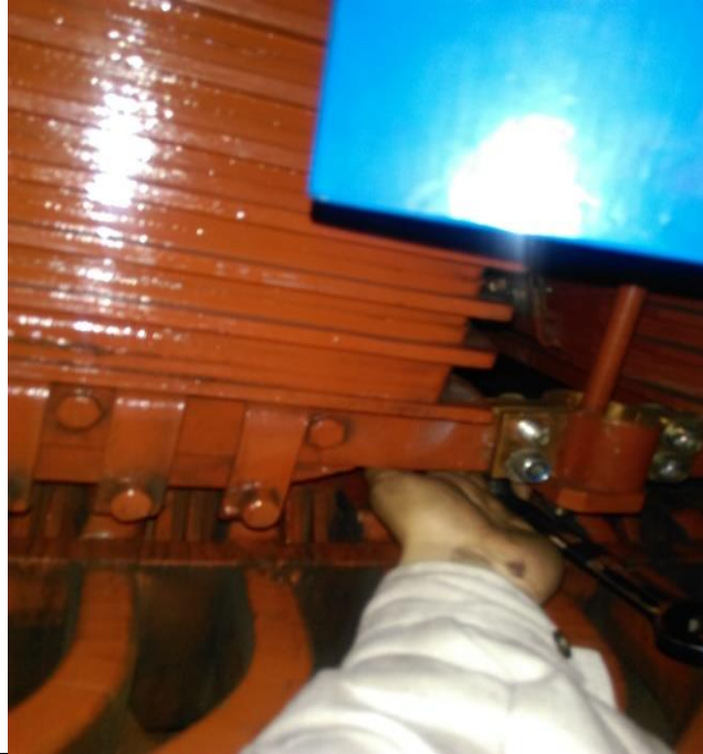
Figura 30: Desconexión de polos.
