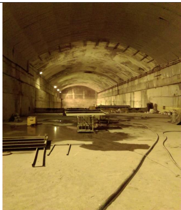
Figura 13: Galería de oscilación para las unidades 3,4 y 5.
