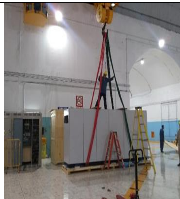
Figura 76: Montaje de AVR 6800.
