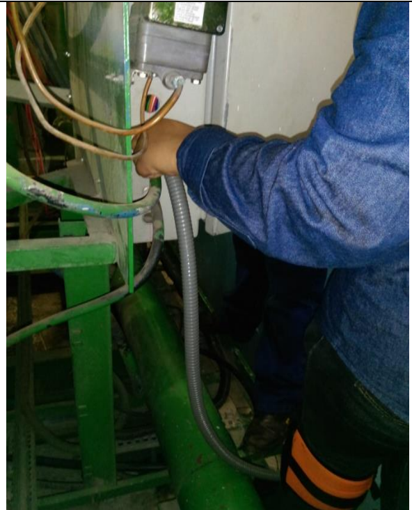
Figura 69: Modificación de tubería.
