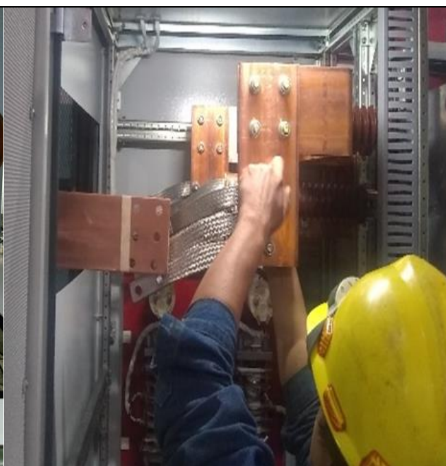
Figura 82: conexión de trenzas.
