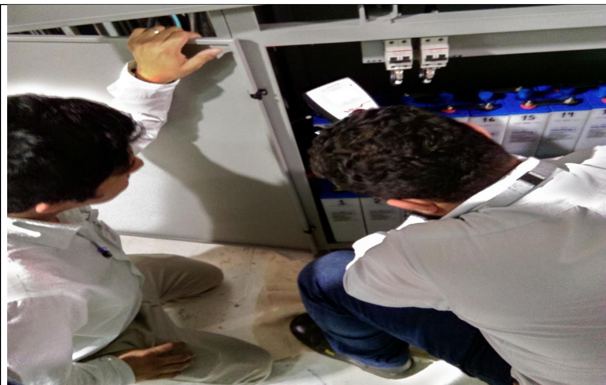
Figura 96: Prueba de densidad del Ácido.
