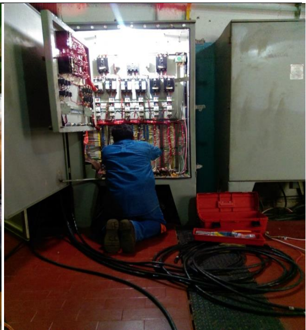
Figura 74: Cableado y conexión de electroválvulas.
