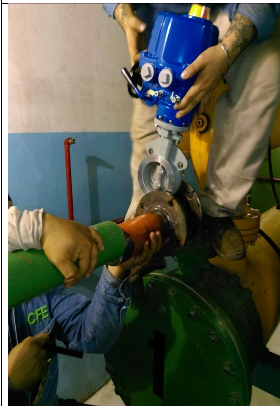
Figura 70: Montaje de Electroválvulas Nuevas.
