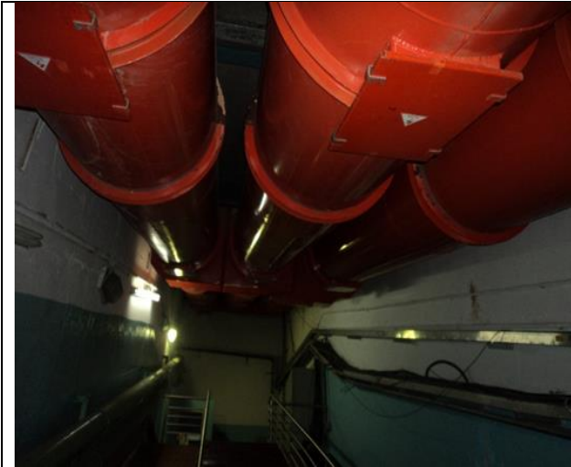
Figura 9: Bus de Fase aislada
