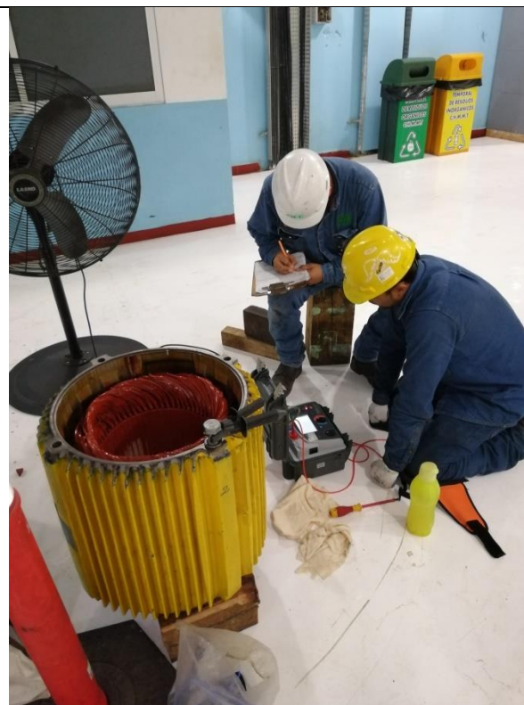
Figura 86: Prueba de resistencia de aislamiento.
