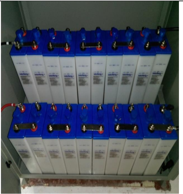
Figura 95: Conexión de baterías.
