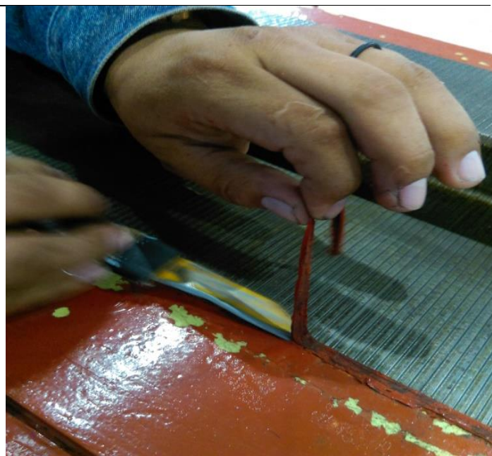
Figura 49: Retiro de aislante desgastado.
