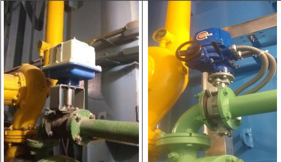
Figura 67: Válvula retirada y válvula nueva.
