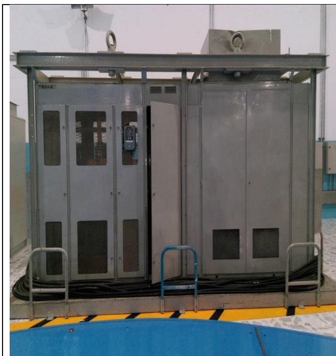
Figura 75: AVR Unitrol D.
