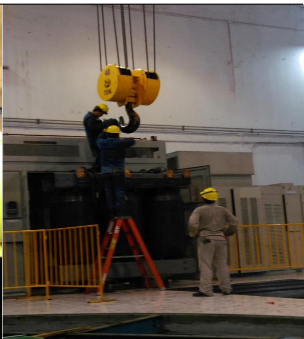
Figura 60: Extracción de Transformador.
