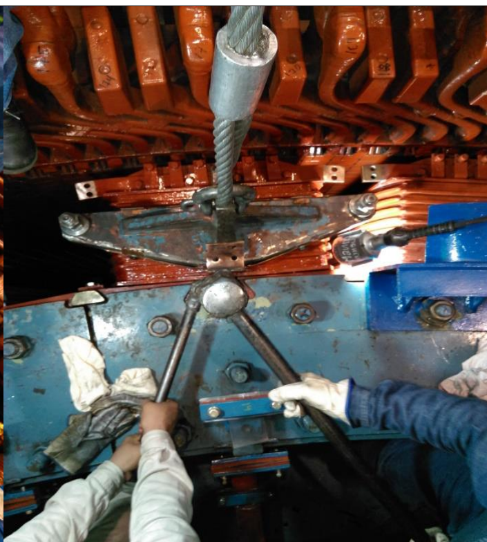
Figura 51: Montaje de polo.
