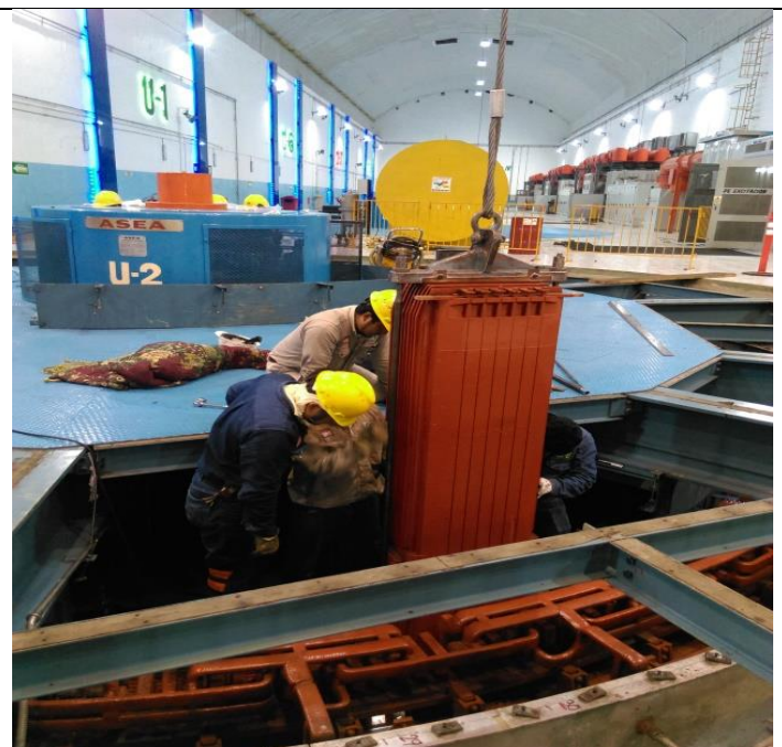
Figura 35: Extracción de polos.
