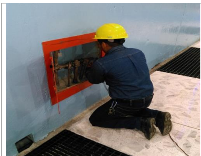
Figura 14: Conexión a tierra de la unidad.
