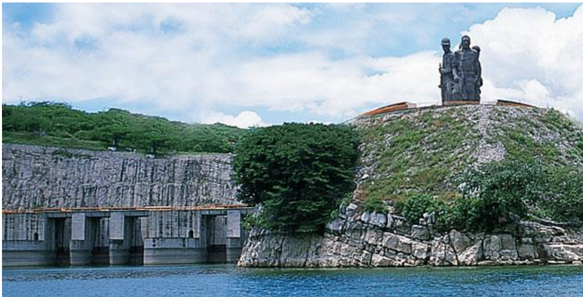
Fig. 5.- Presa Hidroeléctrica Chicoasén, Chiapas
