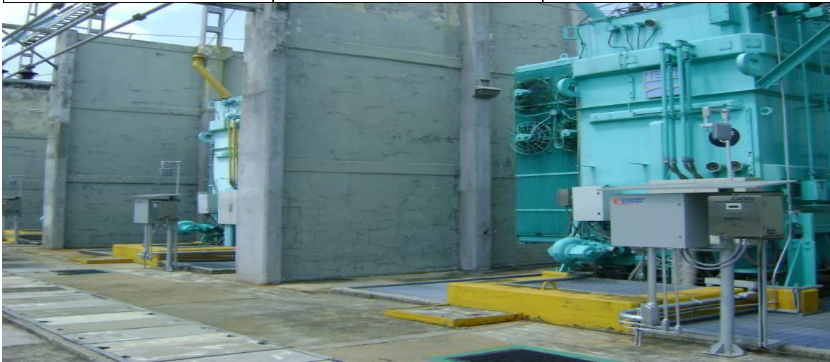
Figura 11. Autotransformador 1-KLV
