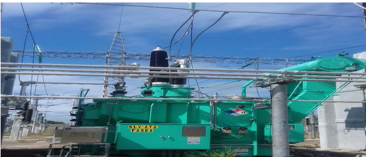
Figura 12. Autotransformador 2-KLV
