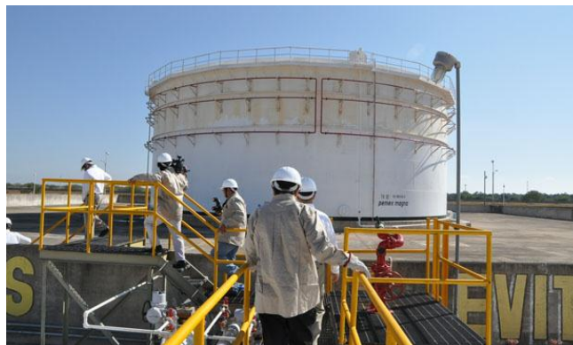
Figura 1. Tanque de almacenamiento de gasolina de Pemex
