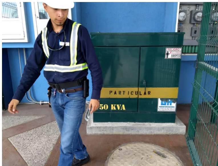
Figura. 3.3 Inspección física y ocular del área.
