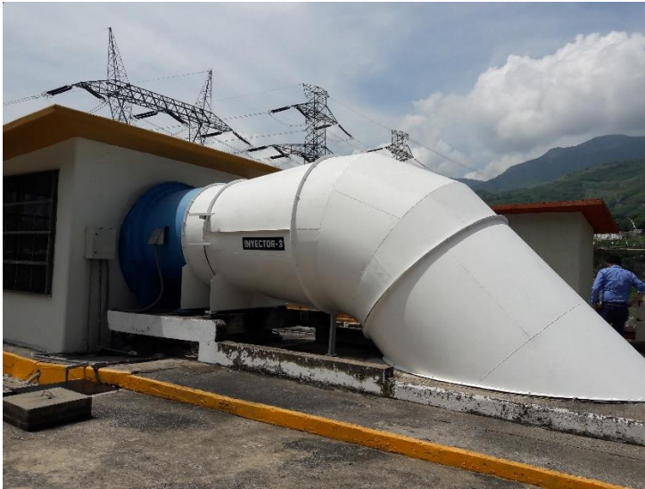
Figura. 4.2 Inyector de aire
