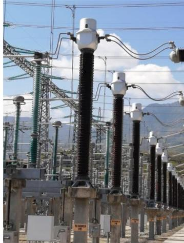
**Fig. 1. Transformador de corriente en la SE MMT**
