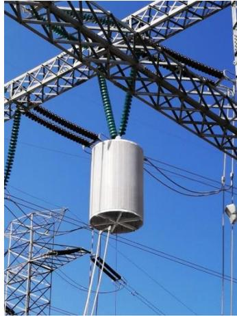
**Fig. 6 Trampa de onda en SE MMT**
