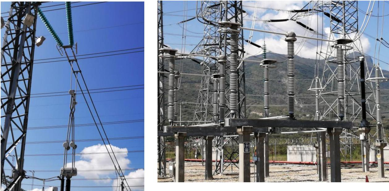
**Fig. 4 Cuchillas en subestación de 400 Kv SE MMT**
