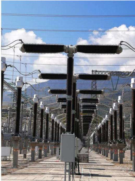
**Fig. 5 Interruptor de 400 Kv SE MMT**
