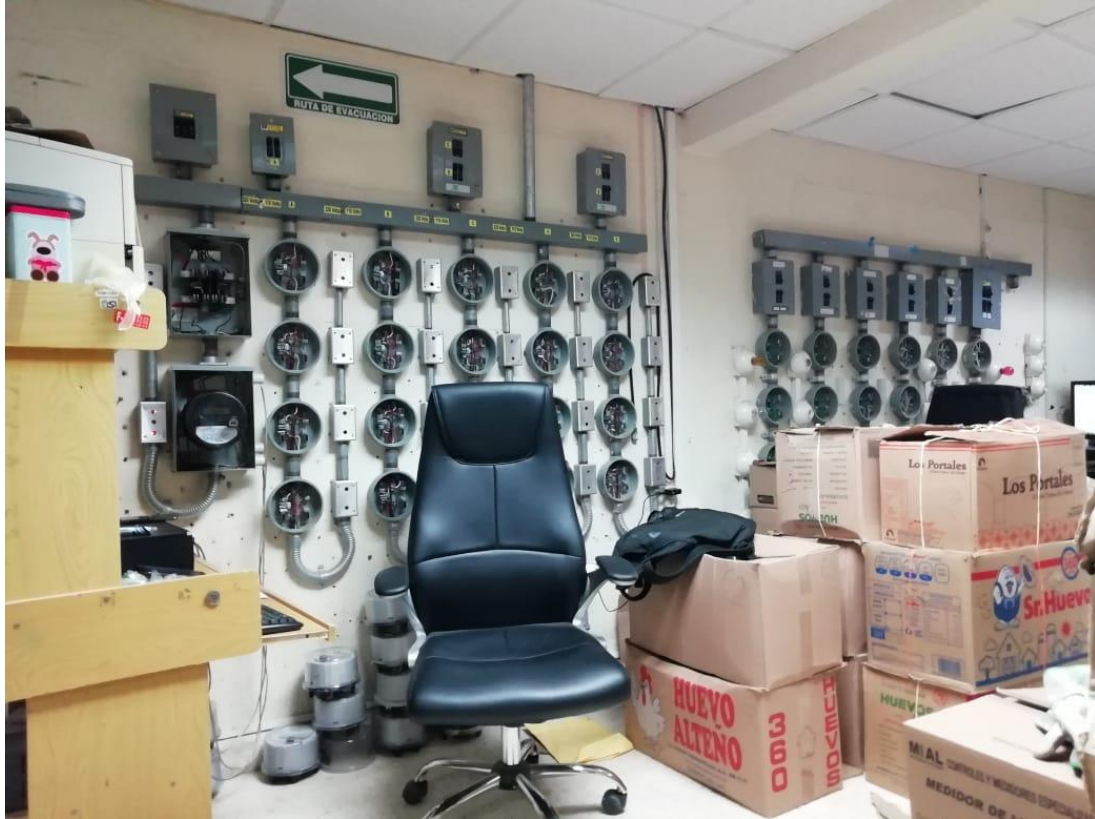
Figura 3. 3 Limpieza e inspección
