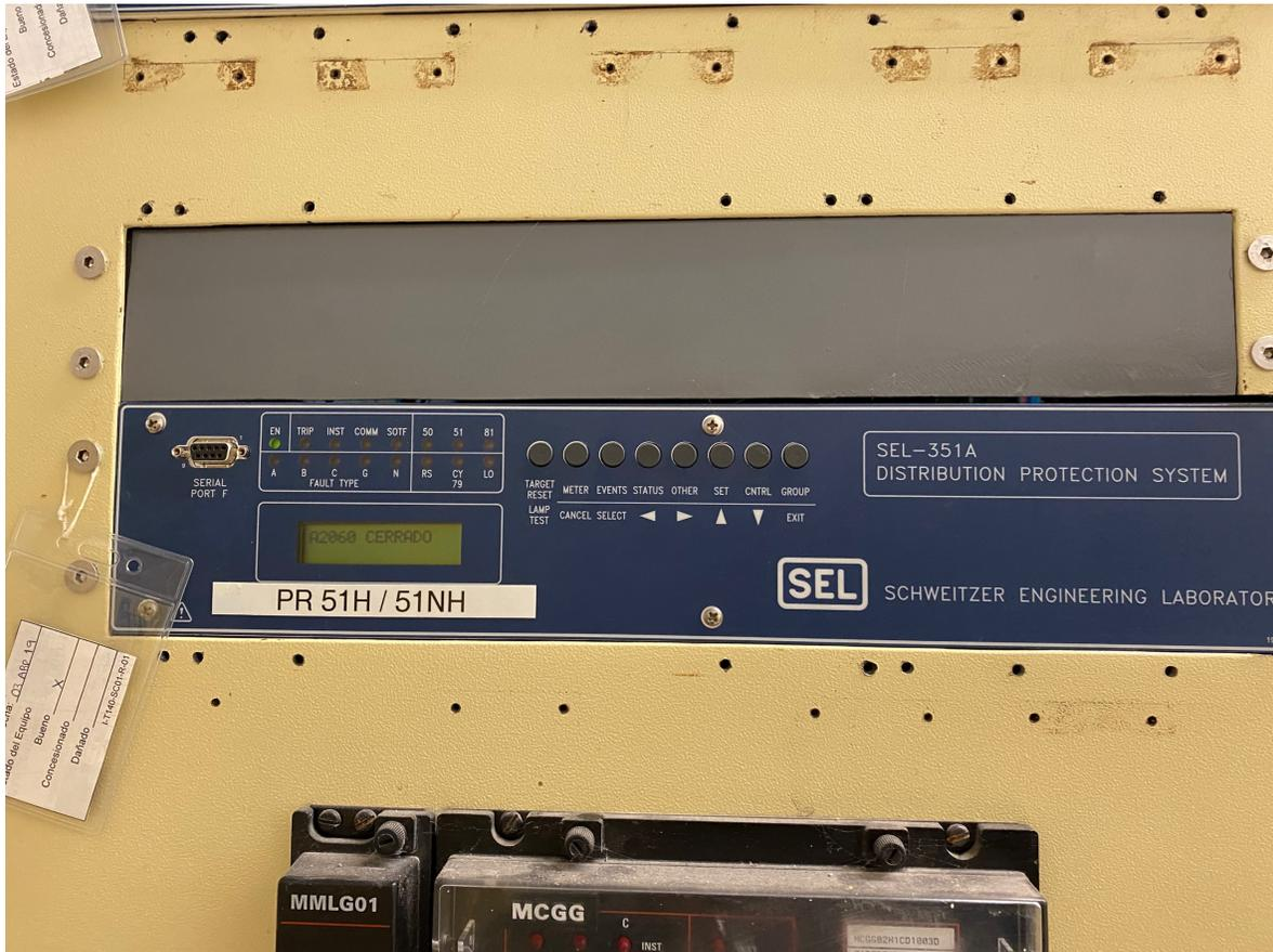
Imagen 21. Relevador SEL-351 “Sistema de protección de distribución”.
