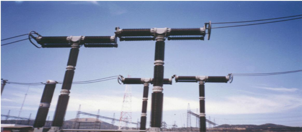
Imagen 7. Transformadores de corriente e Interruptores de Potencia.
