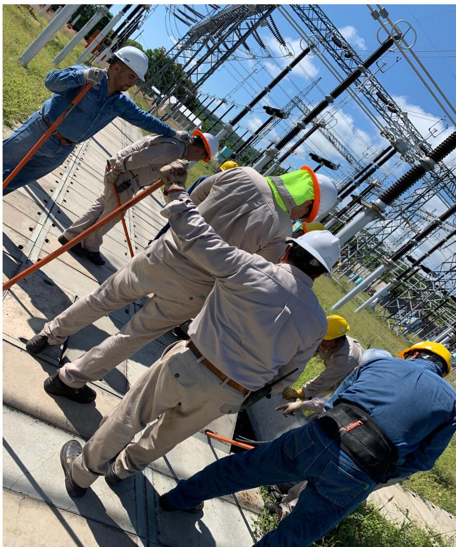
Imagen 26. Levantamiento de tapas de trincheras para la trayectoria de la fibra óptica.
