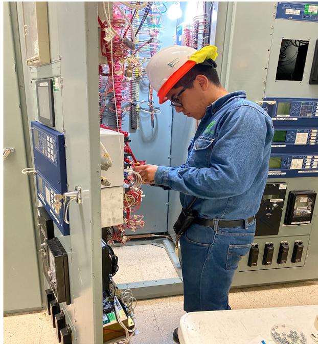
Imagen 54. Conexión alambrado SEL-421.
