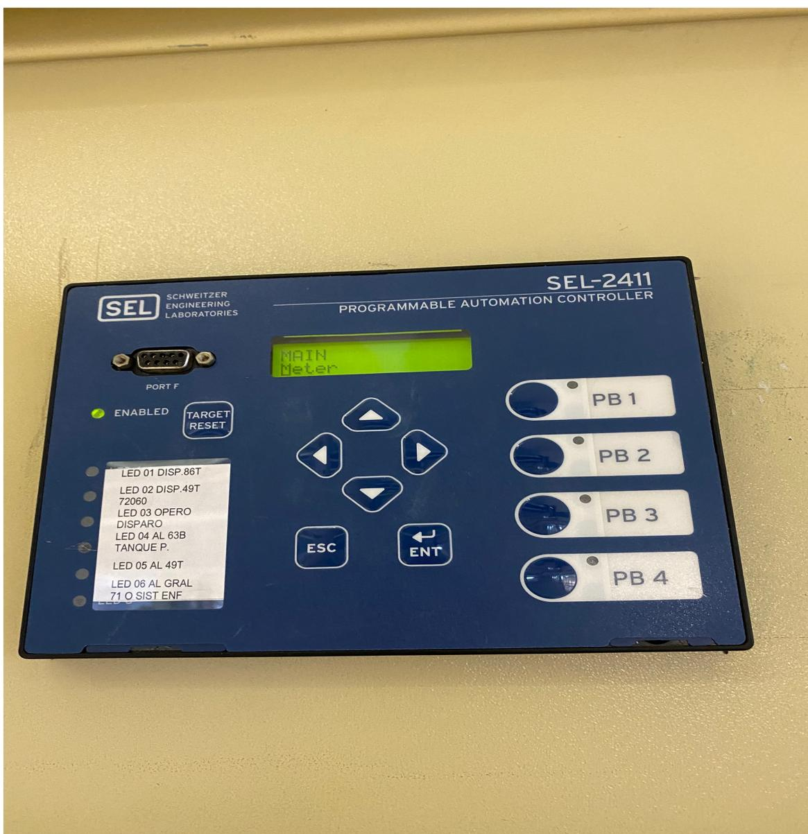
Imagen 24. Relevador SEL-2411: Vista dentro de tablero caseta de control.
