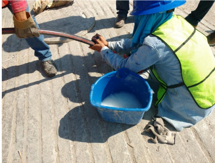
Fig. 3.12 Aplicación de lubricante al cable.
