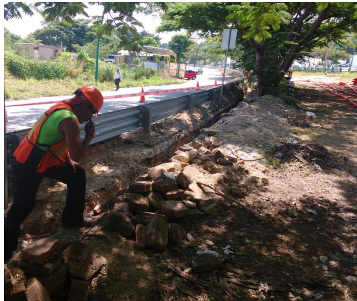
Fig. 3.7 Afinación y compactación de la tierra.
