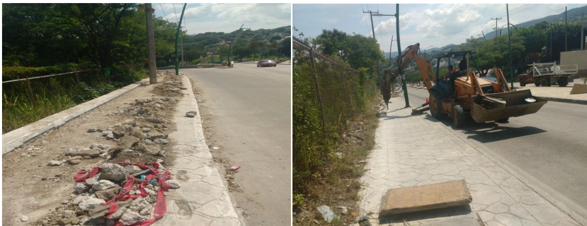
Fig. 3.5 Demolición de concreto.
