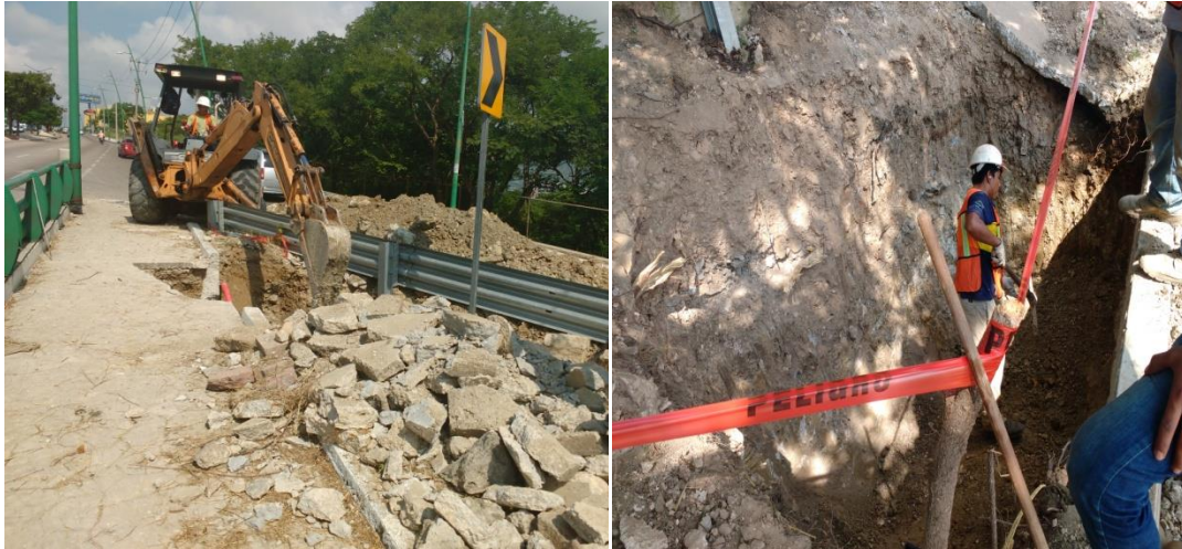
Fig. 3.6 Excavación de canales para pozos y registros.
