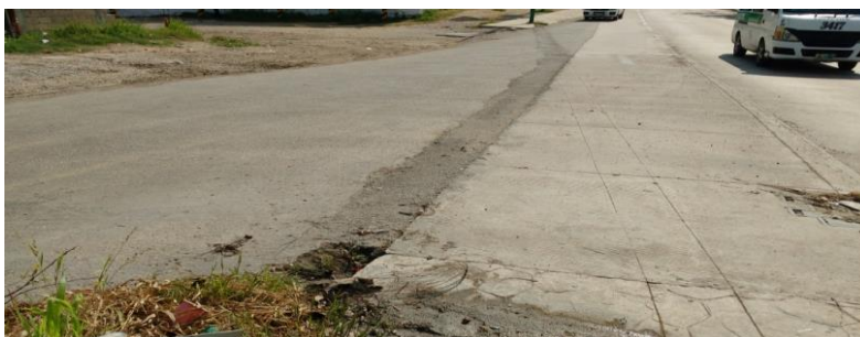
Fig. 3.4 Corte de banqueta y arroyo.
