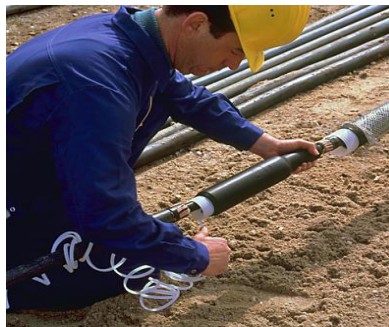
Fig. 2.5 instalación de un empalme en frío.
