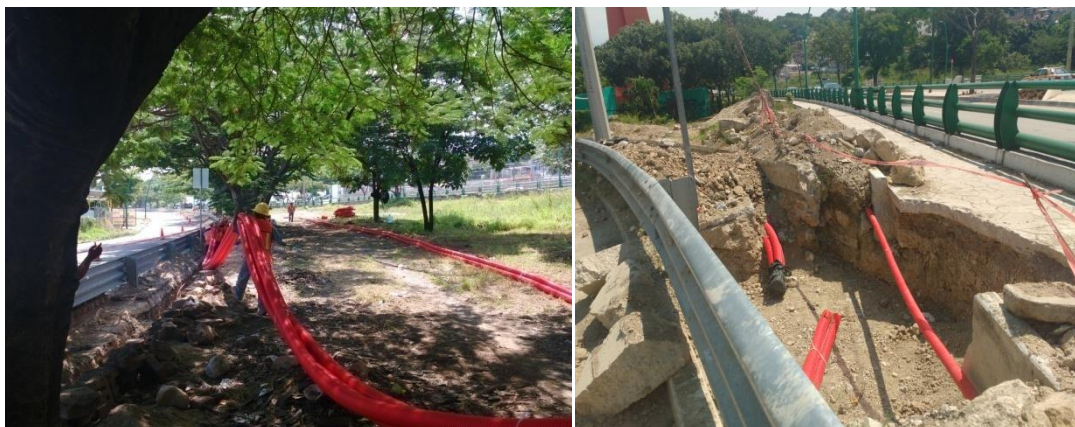
Fig. 3.8 Tendido de tubería padc de 3”.
