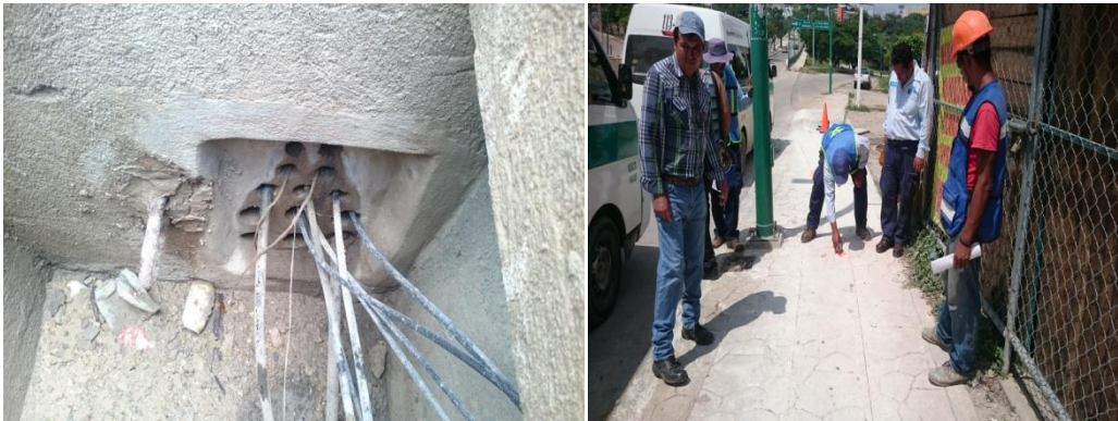
Fig. 3.1 Banco de ductos subterráneo de la empresa TELMEX Fig. 3.2 Identificación de líneas existentes de TELMEX.
