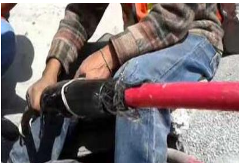
Fig. 3.15 Realización de empalmes.
