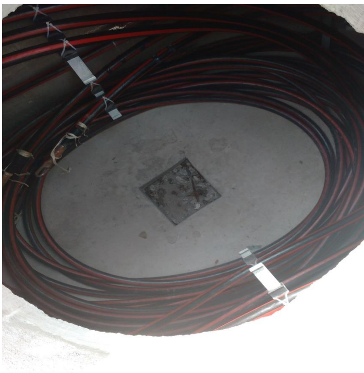
Fig. 3.16 Conductores colocados correctamente en registros.
