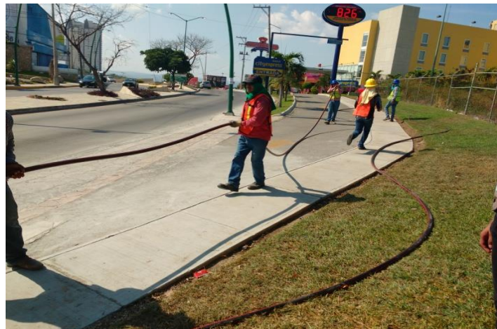
Fig. 3.11 Tendido de cable xlp calibre 500.
