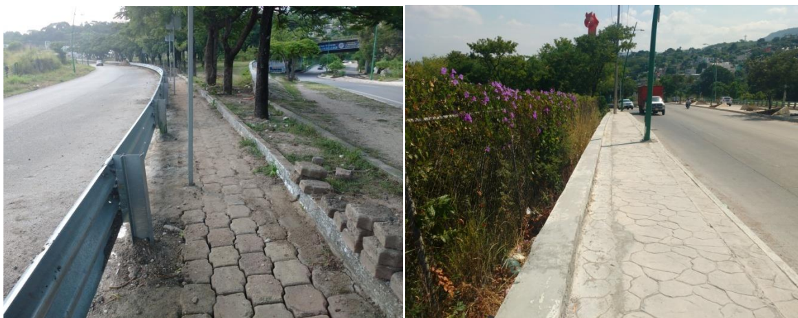
Fig. 3.9 Reposición de concreto.
