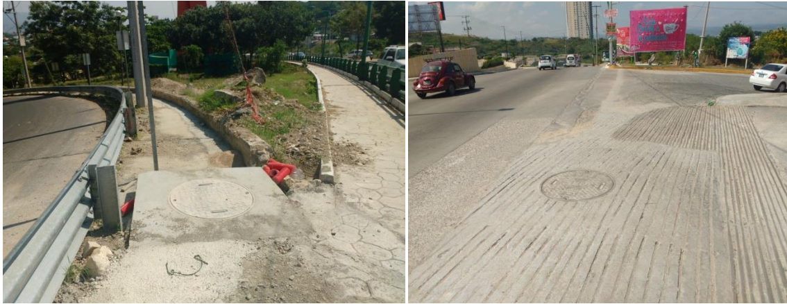
Fig. 3.10 Colocación y resane de registros y pozos.
