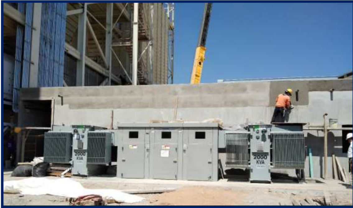
Fig. 4. Construcción de la subestación de la Planta Buenaventura
