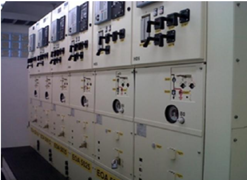
CELDAS FIJAS CON INTERRUPTORES DE POTENCIA TIPO 8DA Y 8D8 HASTA 40,5 KV AISLADO EN GAS
