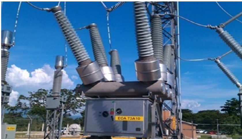
INTERRUPTOR DE POTENCIA DE TANQUE MUERTO EN SF6 123/170 KV
