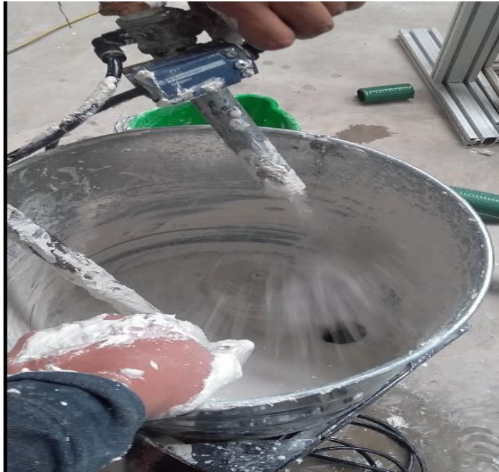
Ilustración 39 proyectado de estuco de forma intermitente
