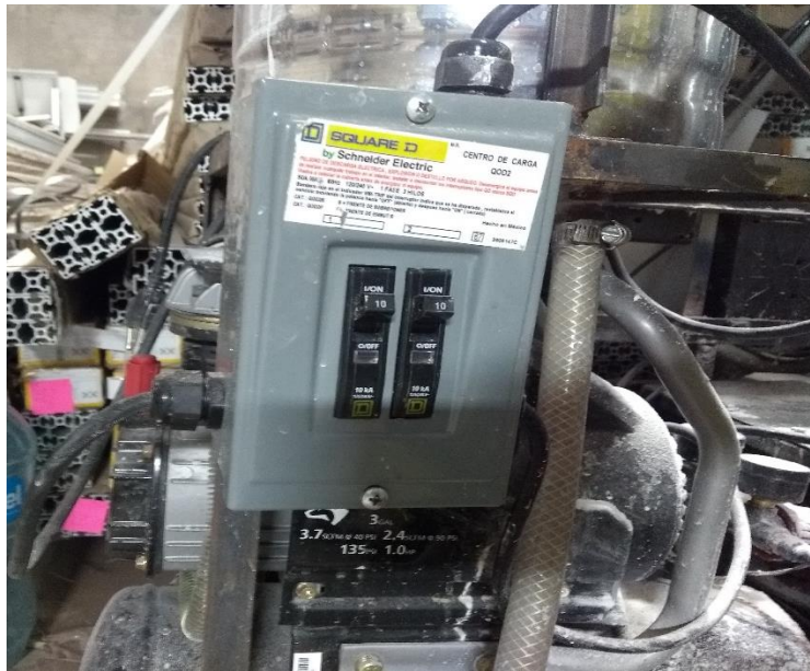
Ilustración 24 centro de carga agregado a mezcladora de concreto.
