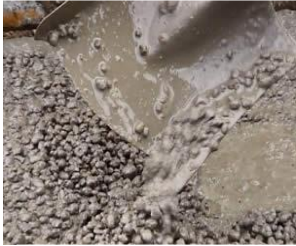
Ilustración 40 mezcla de cemento con grava y agua
