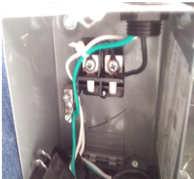
Ilustración 34 corrección del conectado de alimentación
