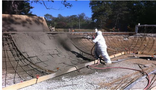
Ilustración 1 proyectado en estructuras semi-armadas
