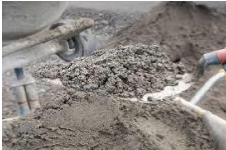
Ilustración 41 retirando mezcla de cemento con grava del depósito
