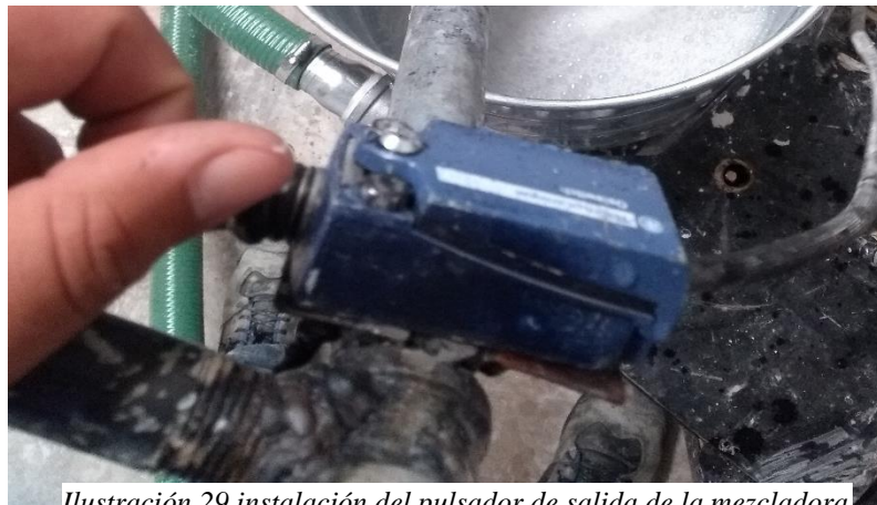
Ilustración 29 instalación del pulsador de salida de la mezcladora
