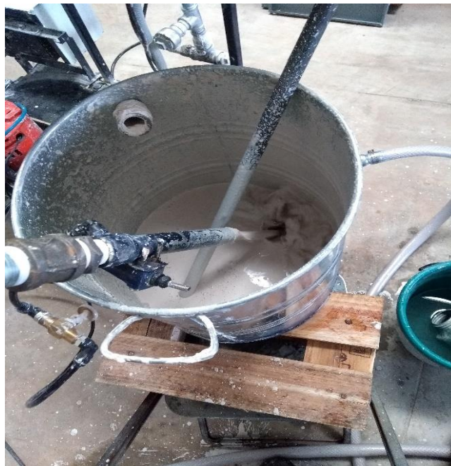
Ilustración 35 bombeo de la calhidra en forma de pasta
