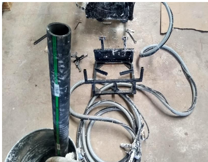
Ilustración 43 limpieza de la manguera de bombeo con agua
