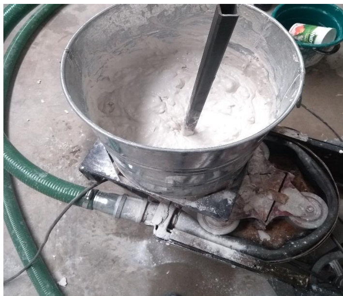
Ilustración 37 mezcla de estuco listara para ser proyectada
