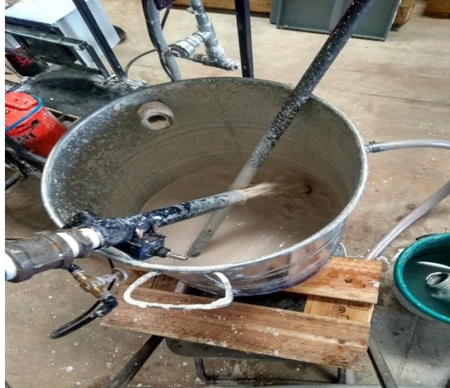
Ilustración 36 proyección de calhidra con aire comprimido
