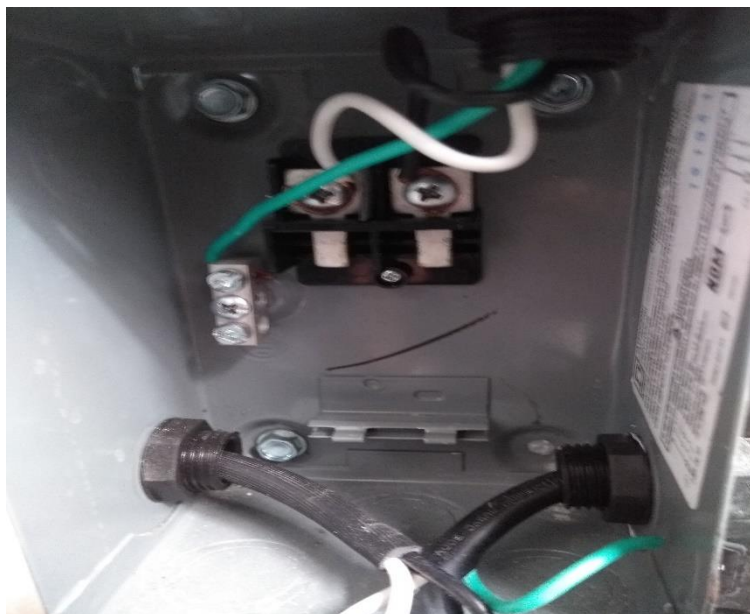
Ilustración 33 error en la conexión de alimentación en los ITM
