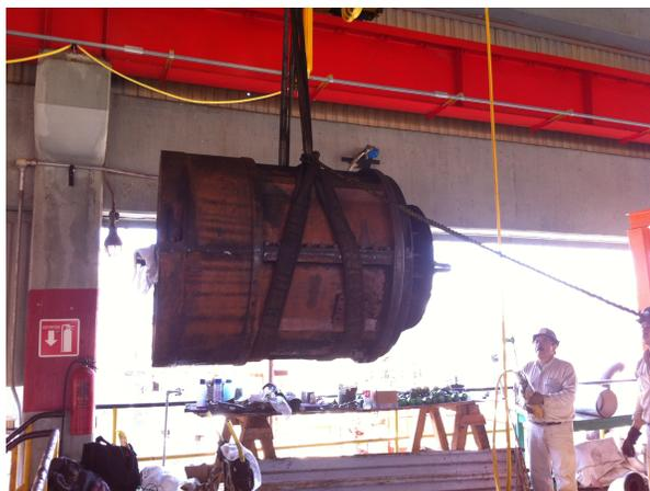
Fig. No.13. Maniobra para extraer el barril del compresor.
