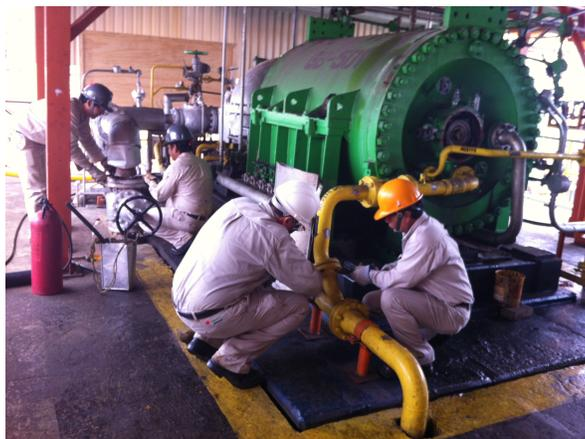
Fig. No. 20. Embridado del sistema de lubricación del compresor.
