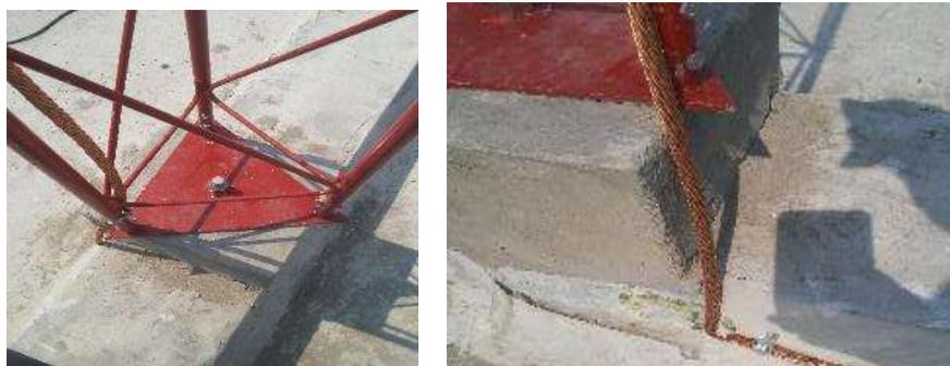
*Figuras 37.-Conexión del conductor pararrayo.*
