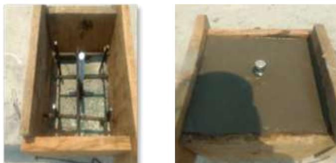
*Figuras 30.- Se realizó dado de concreto con varillas*
