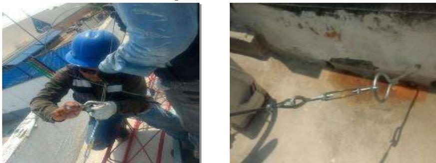
*Figuras 34.-Instalación de retenidas a las anclas de pared.*
