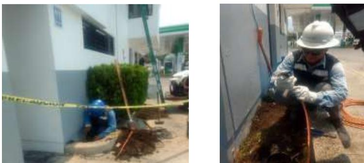
*Figuras 29.- La instalación del conductor pararrayos.*
