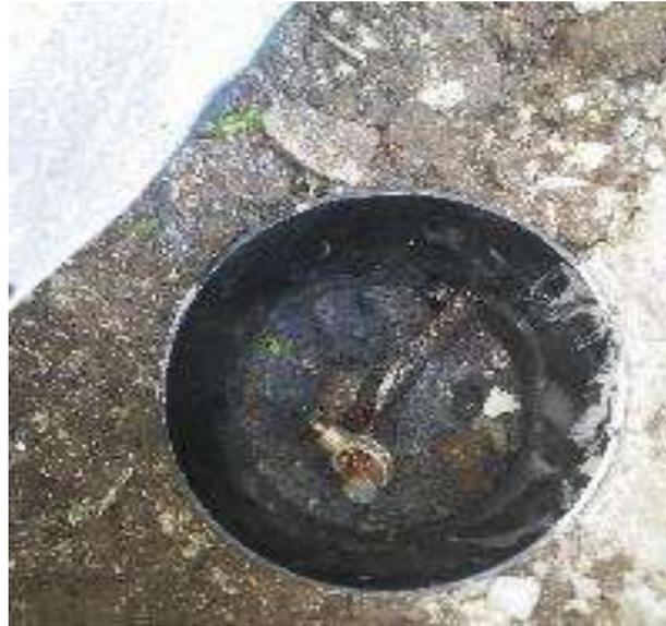
*Figura 40.- Conexión del conductor de cobre trenzado de 28 hilos a las varillas cooperweld del sistema puesta a tierra.*
