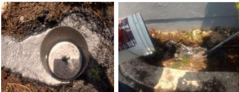
*Figuras 28.- Instalación de varillas para tierra física.*
