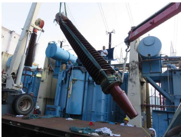
Fig.5.22 Maniobra para colocar la boquilla.
