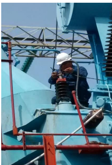
Fig. 5.16 conectando a tierra boquilla H0.
