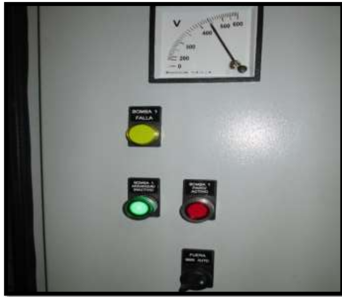
Fig. B.2 Tablero de vista Frontal para su Arranque/Paro y selector de Posición.
