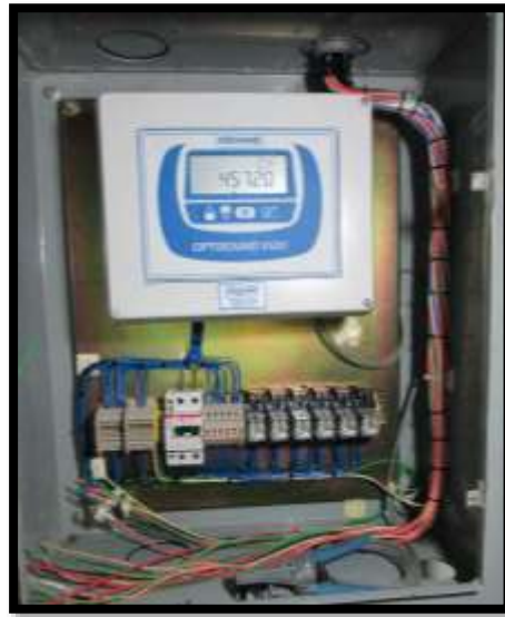
Fig. 3.3 Puesta en servicio y tomas de nivel del Cárcamo.
