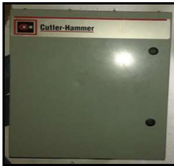
Fig. B.1 Gabinete de protección para montaje del Sistema de control de medición.
