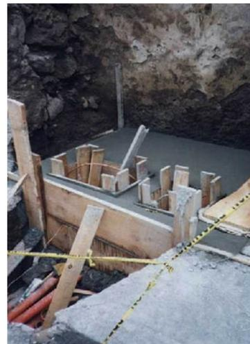
Una vez instalado el registro se debe cuidar la conexión con el ducto. La unión debe quedar perfectamente sellada con pasta cemento-arena incluyendo un adhesivo de concreto, redondeando todas las aristas para evitar daños al cable, dejando un abocinado.
