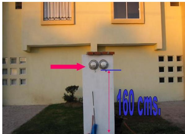
La preparación para recibir la acometida debe estar en el límite de la propiedad. El interruptor no debe estar a más de 5 metros del medidor y el neutro no debe estar conectado a ningún medio de protección.
