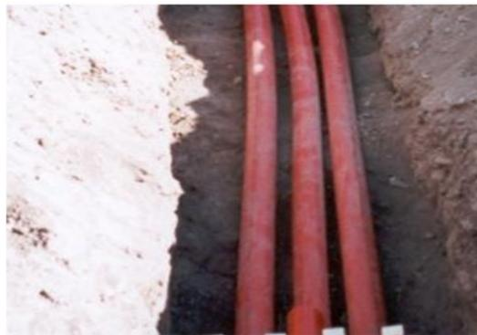
Se colocara una cinta de advertencia en la parte superior del banco. En caso de utilizar ductos PAD los tramos de tubo deben ser de una sola pieza entre registros. Si se utilizan coples deben ser para PAD o se deben termofusionar los tramos para acoplar.
