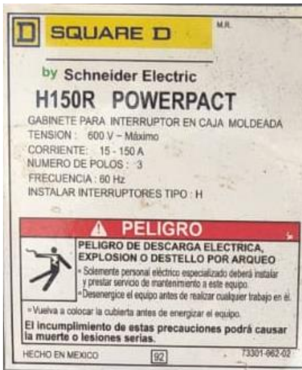
Figura 3.6.4 Característica de gabinete para interruptor en caja moldeada
