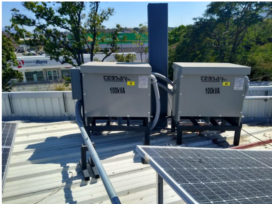
Figura 4.2.9 Transformadores 220/480 V
