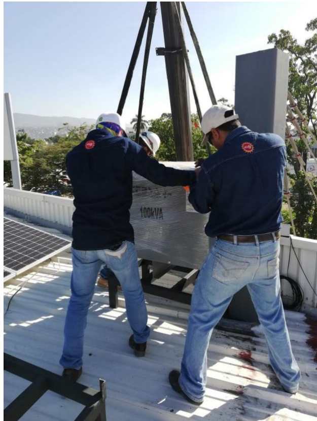
Figura 4.2.7 Colocación de transformador tipo seco 220/480 V
