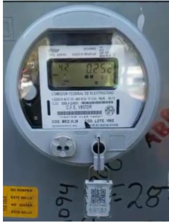
Figura 4.2.12 Medidor bidireccional
