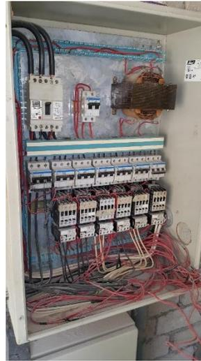
**Fig.** Armado de gabintes de protecciones de motores, sistema de control y conexionado de las mismas.
