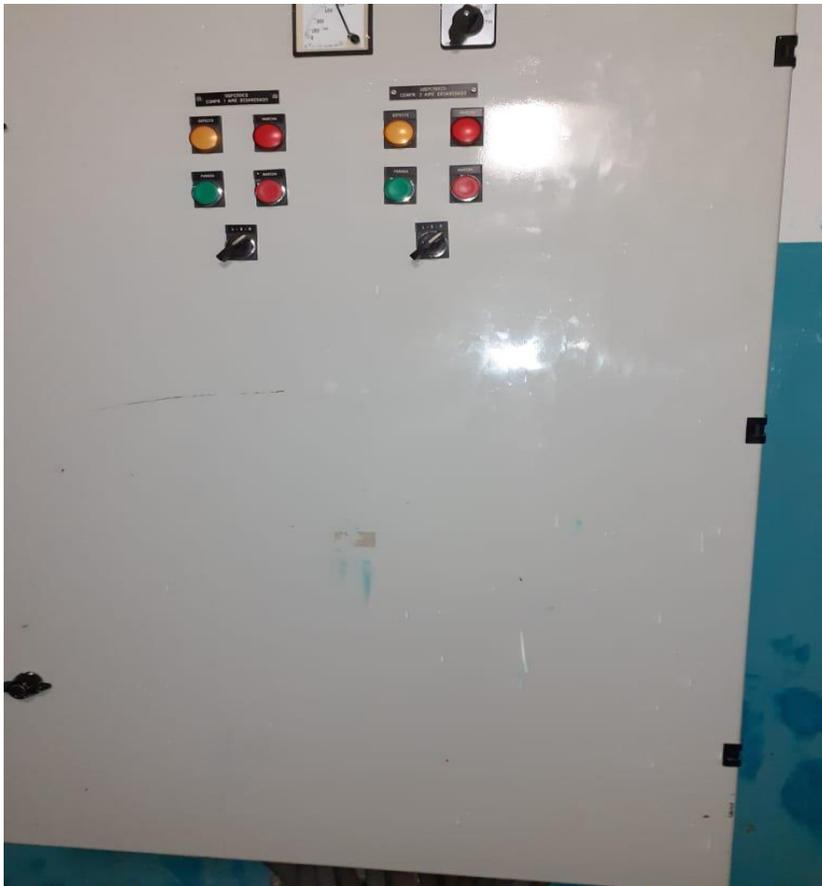
FIGURA 3.2 TABLERO DE COMPRESORES
