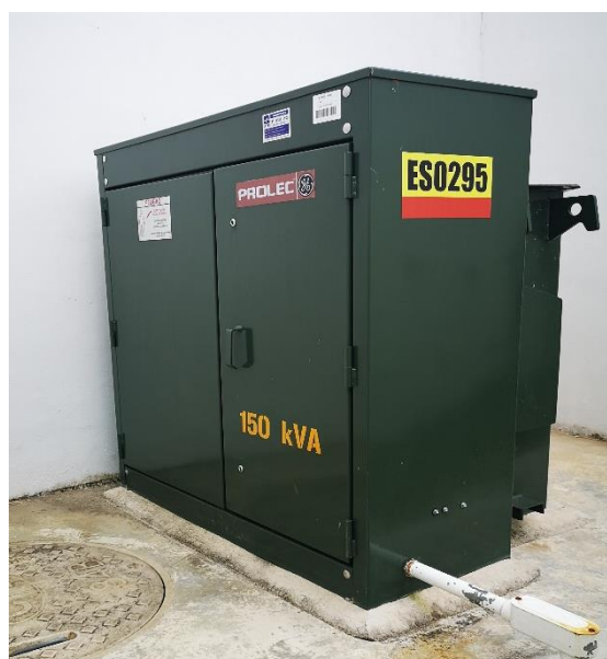
Figura 5. Transformador instalado
