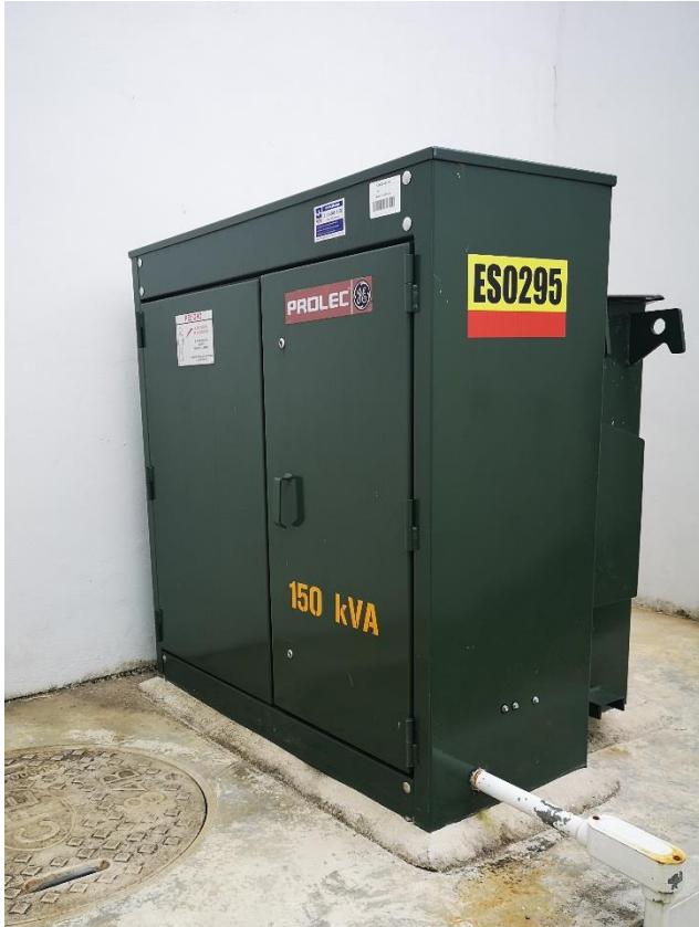
Figura. 14. transformador instalado
