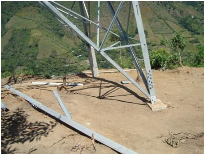
FIG. 06 VISTA DEL RELLENO Y COMPACTADO
