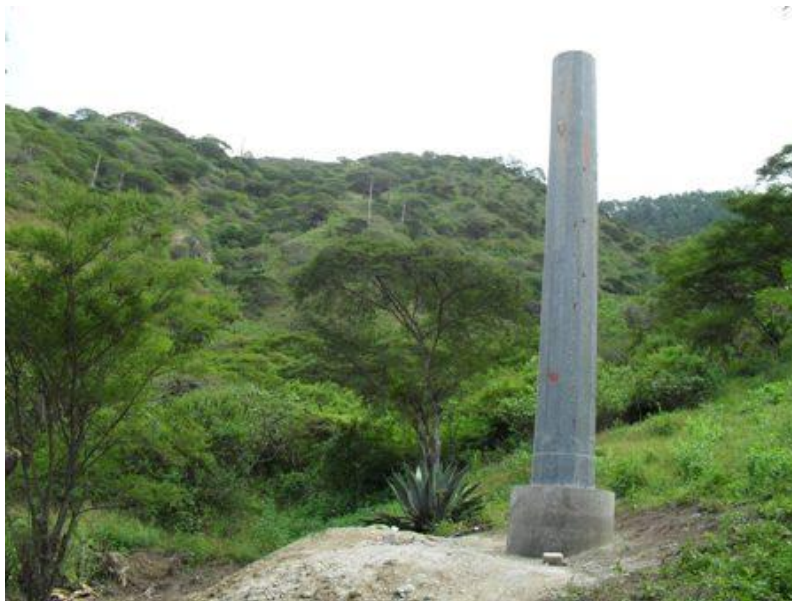
FIG. 12 PARADO Y PLOMEADO DE 1RA. SECCIÓN DE POSTE TRONCOCÓNICO
