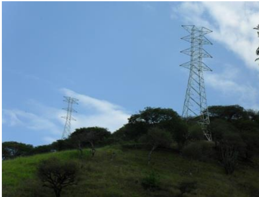
FIG. 11 VISTA PANORÁMICA DEL ARMADO DE 2 ESTRUCTURAS DE LA L.S.T.
