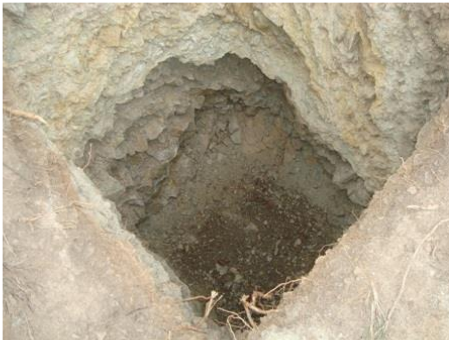
FIG. 07 EXCAVACIÓN DE CEPAS PARA POSTE
