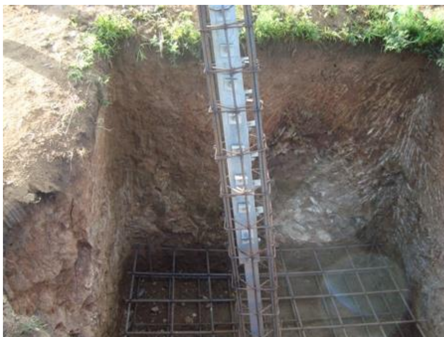
FIG 04 VISTA EXTERIOR DE UNA CIMENTACIÓN
