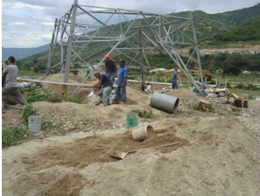
FIG. 10 PERSONAL DEL CONTRATISTA TRABAJO EN LA NIVELACIÓN DEL BOTTOM PANEL DE ESTRUCTURA
