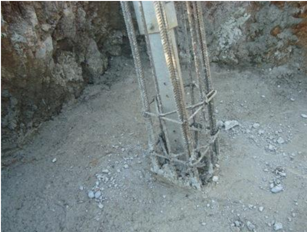
FIG 05 VISTA INTERIOR DE UNA CIMENTACIÓN
