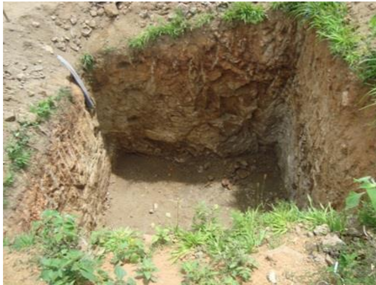
FIG 03 EXCAVACIÓN PARA UNA ESTRUCTURA
