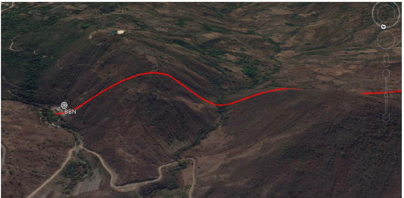
FIG. 35 VISTA ACTUAL DE LA TRAYECTORIA DEL CICUITO JUY-4030 SOBRE LA S.E. BOMBANA
