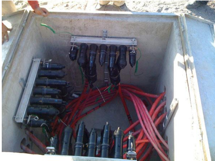
FIG. 15 SISTEMA DE DISTRIBUCION SUBTERRANEA.
