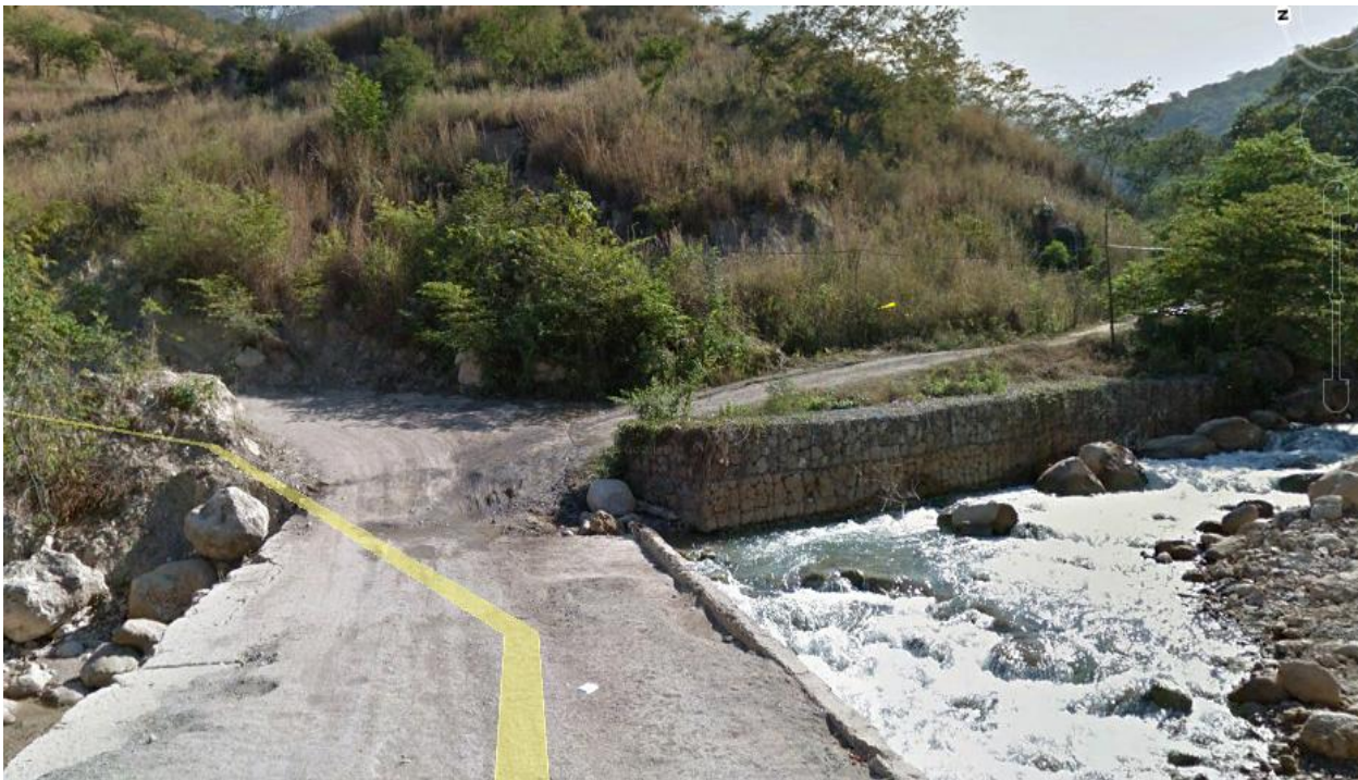
FIG. 38 SALIDA DE LA REPRESA BOMBANA PARA CIRCUITO JUY-4030.
