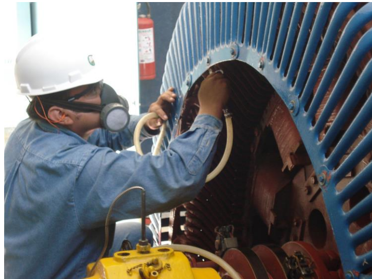
Fig 3. Limpieza del estator con Dielectrol
