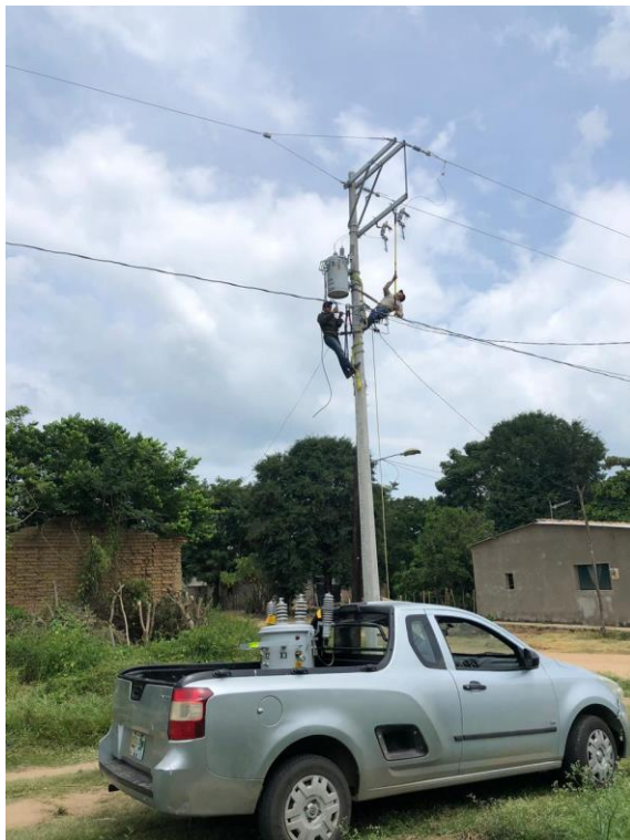
Foto 50 Suministro y colocación de transformador.
