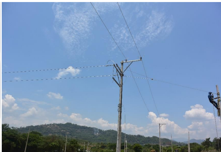
Foto 33 Tendido de cable AAC Cal. 3/0 en estructura VS30/VR30.
