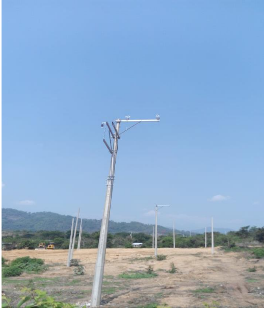
Foto 7 Empotramiento de postes.
