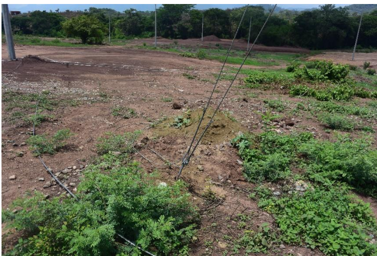
Foto 27 Retenida doble estaca ancla sencilla.
