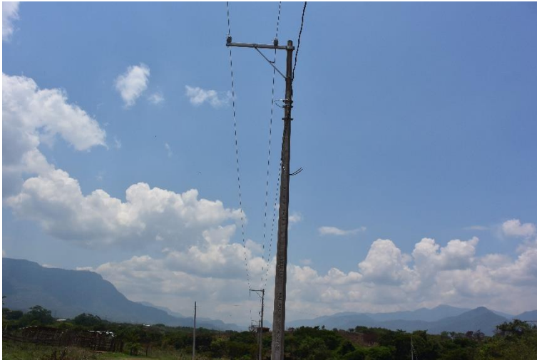
Foto 34 Tendido de cable AAC Cal. 3/0 en estructura VS30.
