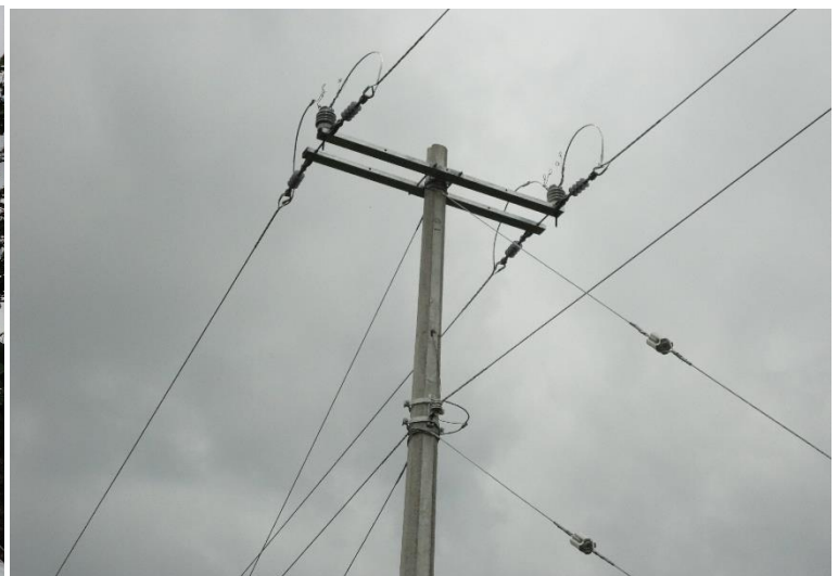
Foto 36 Tendido de cable AAC Cal 1/0 en estructura VA30.
