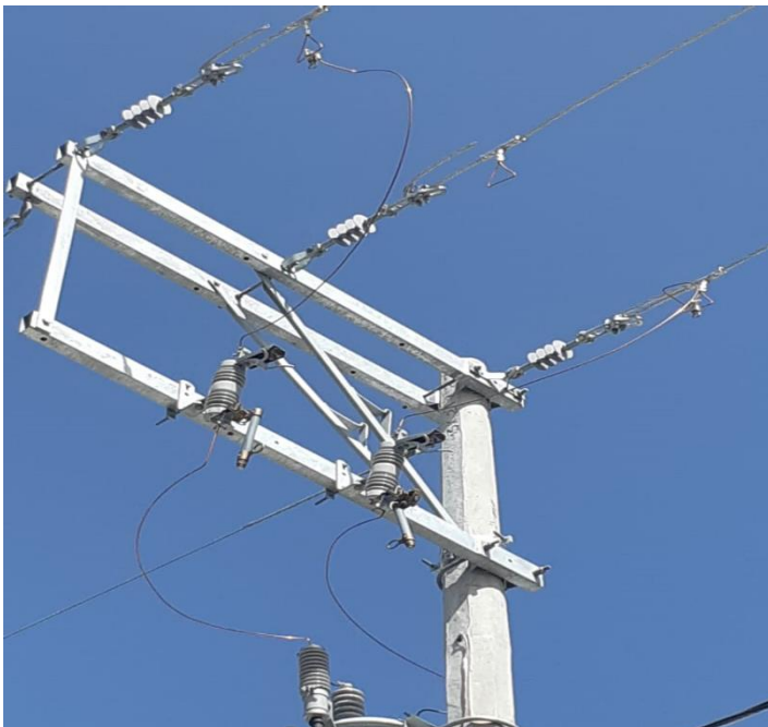
Foto 53 Suministro y colocación de listón fusible.
