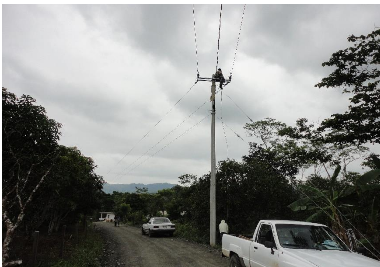
Foto 35 Tendido de cable AAC Cal. 1/0 en estructura VA30.
