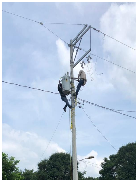
Foto 49 Suministro y colocación de transformador.
