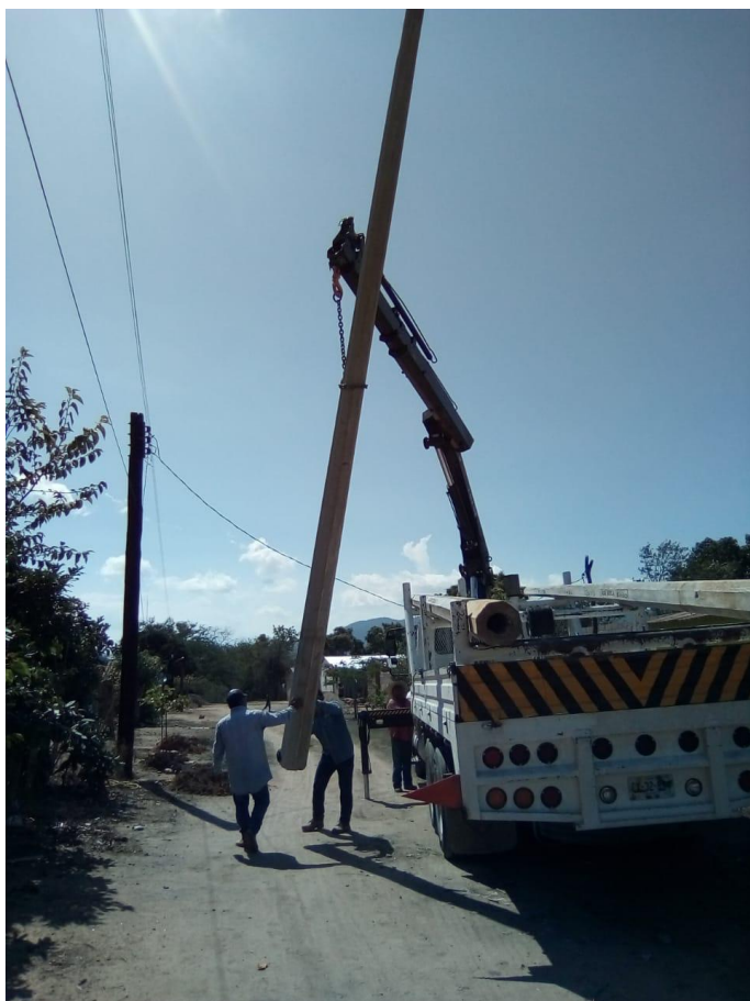
Foto 5 Empotramiento de postes.
