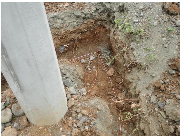
Foto 46 Suministro de alambre de cobre desnudo cal. 4
