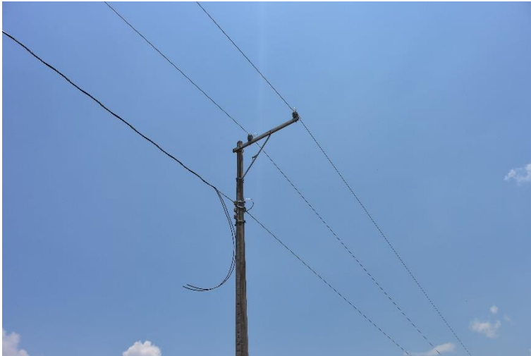
Foto 37 Tendido de cable AAC Cal. 1/0 en estructura VS30.
