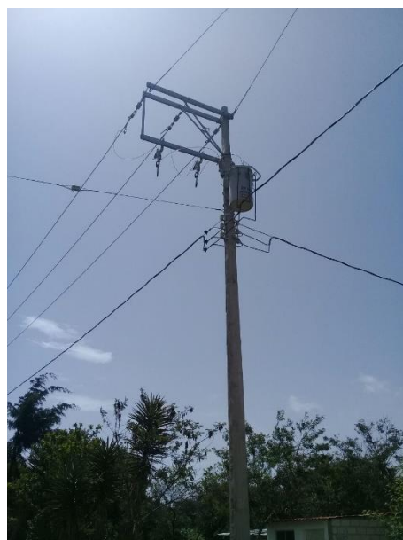
Foto 43 Tendido de cable neutranel en estructura 1P3/1R3.
