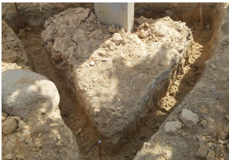
Foto 44 Excavación e instalación de varilla copperweld 3x5/8.
