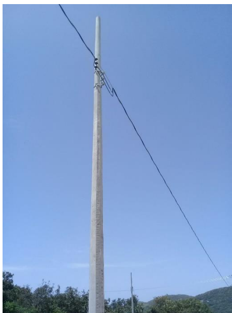
Foto 41 Tendido de cable neutranel en estructura 1P3.
