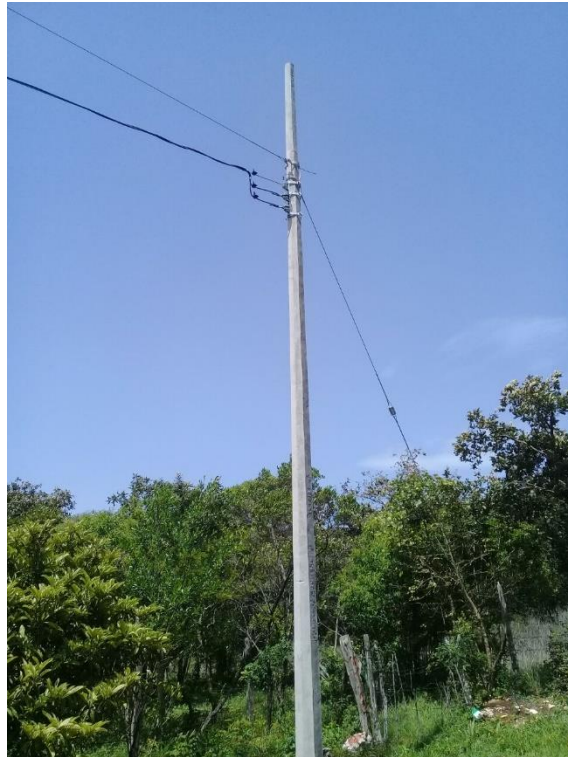
Foto 39 Tendido de cable AG Cal. 5/16 en retenida RPP.
