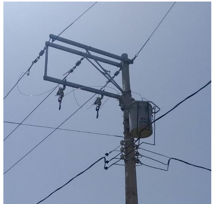
Foto 54 Suministro y colocación de listón fusible.
