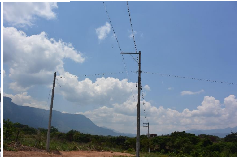
Foto 40 Tendido de cable AG Cal. 5/16 en retenida tipo REA baja tensión,
