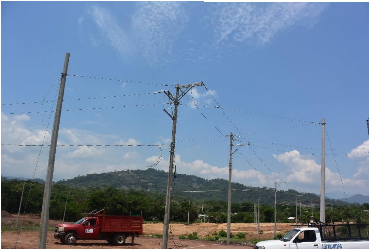
Foto 38 Tendido de cable AG Cal. 5/16 en retenida REA media tensión.
