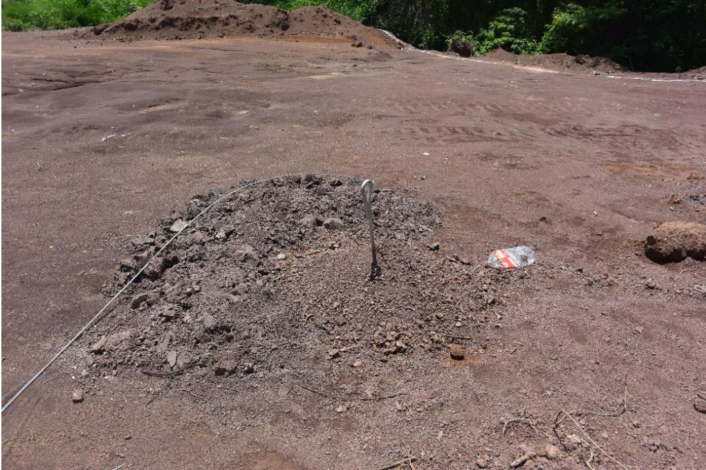
Foto 9 Cepa, perno ancla para retenida RSA.
