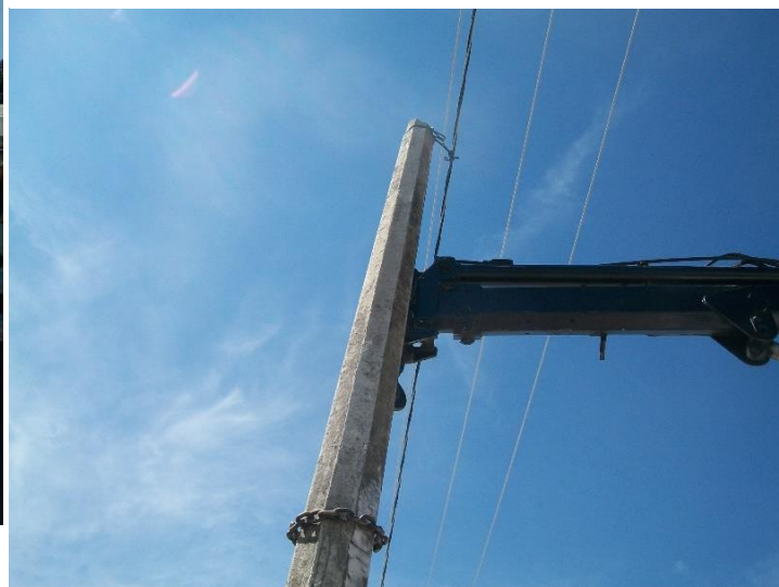
Foto 3 Maniobras con la grúa tipo HIAB.
