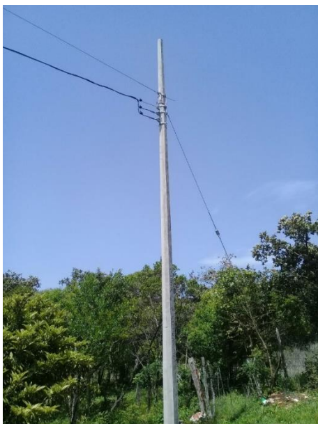
Foto 42 Tendido de cable neutranel en estructura 1R3.
