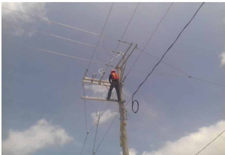
Foto 32 Tendido de cable AAC Cal. 3/0 en estructura VR30/VR30.
