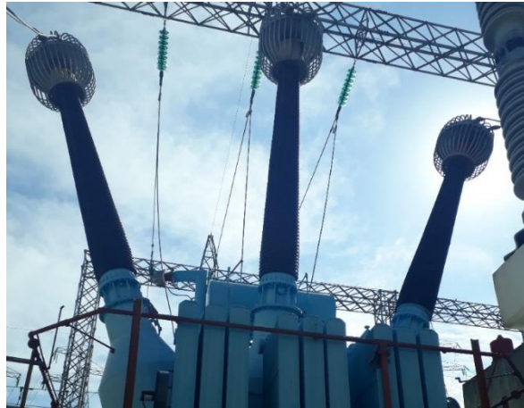
Figura 3.8 Boquillas de Alta tensión del Transformador T-7 MPU
