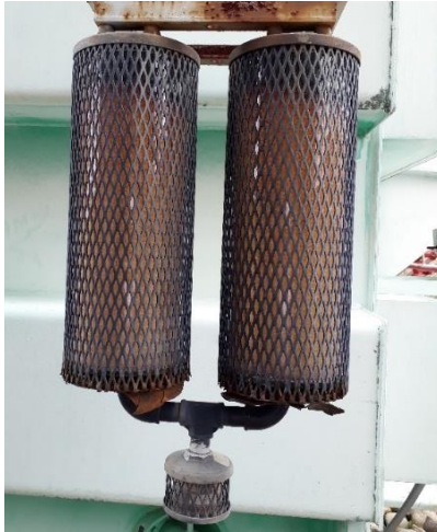
Figura 3.18 Respiración mediante silica gel del AT-2 Fase A MPD
