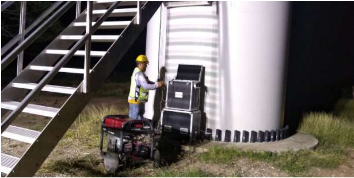
COLOCACIÓN DEL EQUIPO Y TODOS SUS ELEMENTOS.
