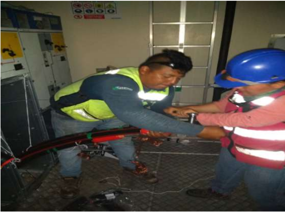
PREPARACION DE CABLES (TAPONEO DE FASES).
