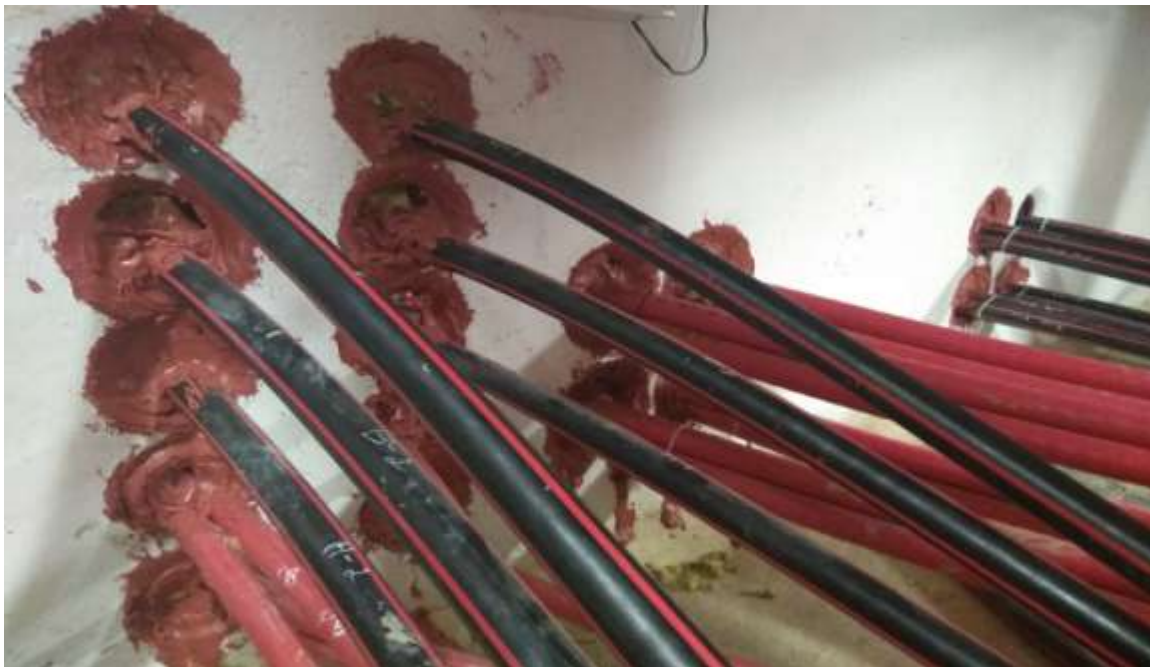
INSPECCION PREVIA AL AREA.
