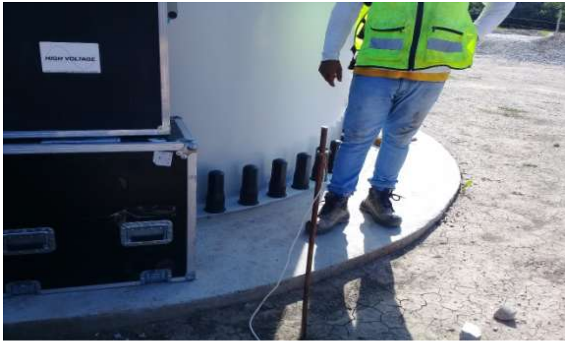
VARILLA DE TIERRA PARA ATERRIZAMIENTO DE GENERADOR EN PRUEBAS VLF.
