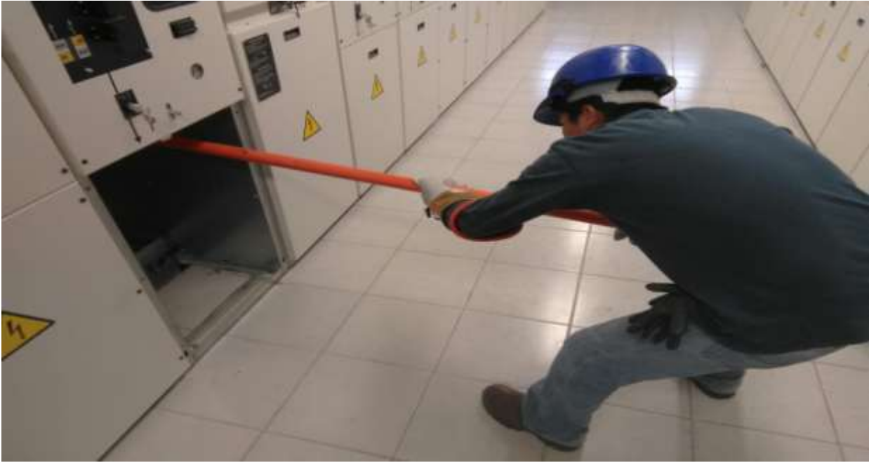
INSPECCIONES AL AREA CON EL DETCTOR DE AUSENCIA DE TENSION.
