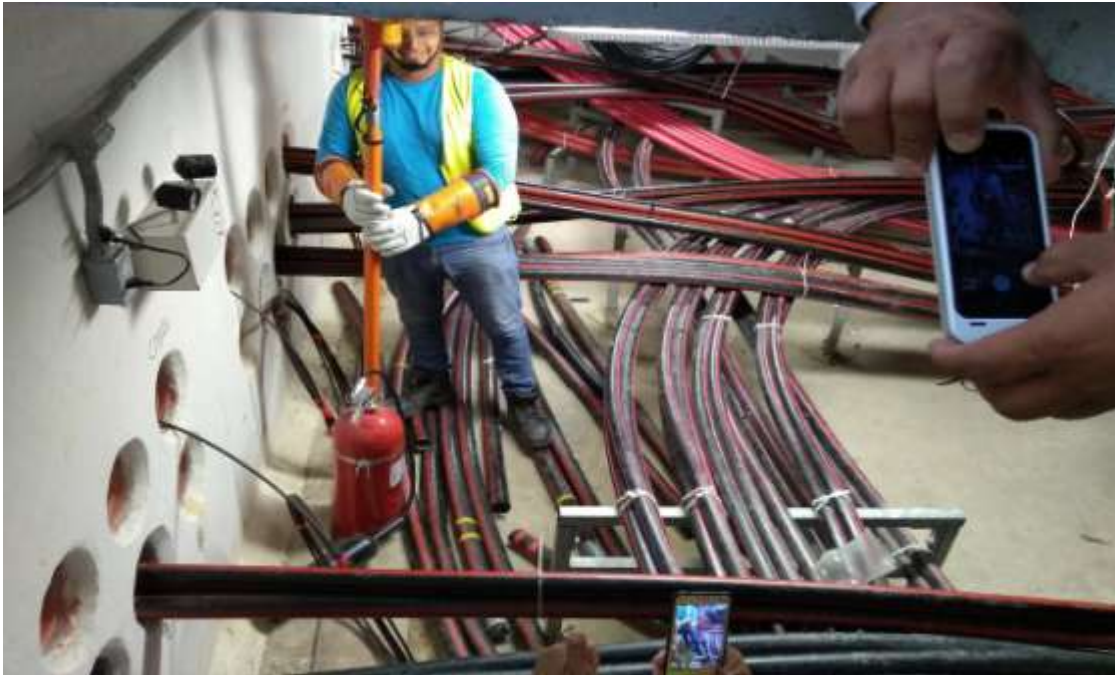
INSPECCIONES AL AREA CON EL DETCTOR DE AUSENCIA DE TENSION.
