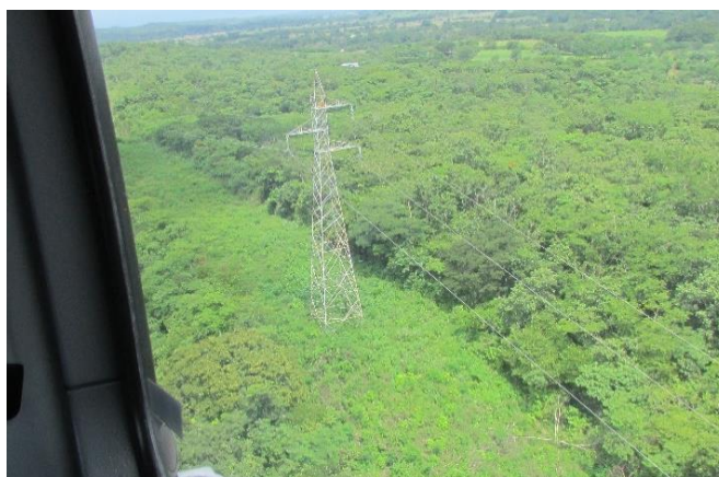
Ilustración 63 Falla Repetida en Estructura #11.
