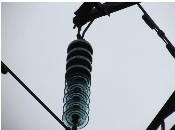
Ilustración 6 Cadena de Aisladores Combinado (Vidrio Templado y Porcelana).
