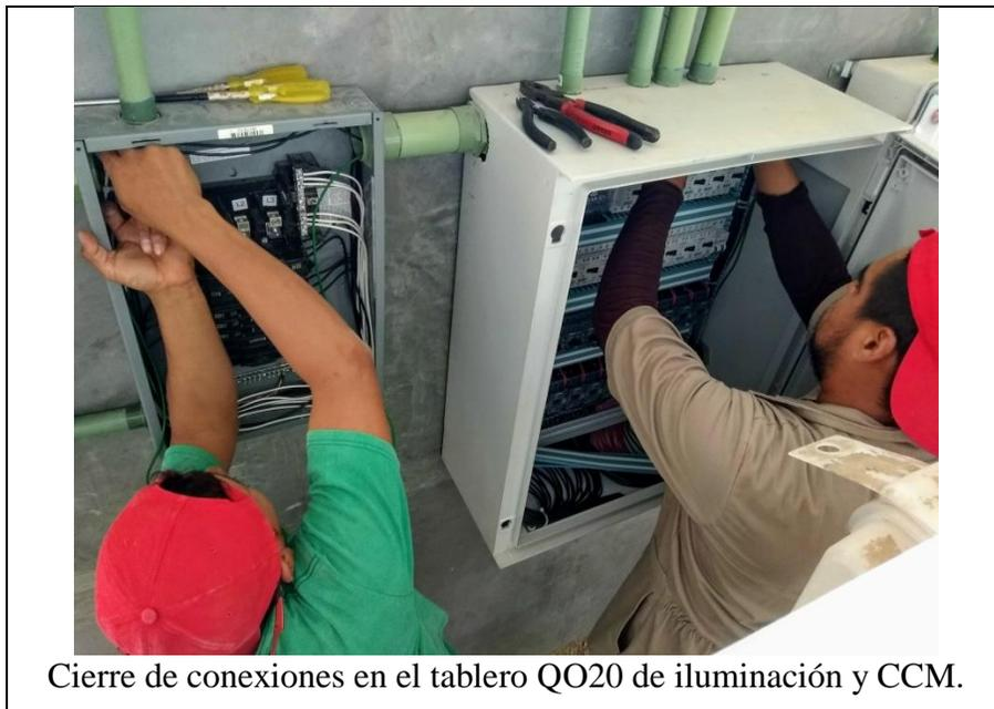
Cierre de conexiones en el tablero QO20 de iluminación y CCM.
