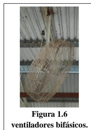
Cada sala cuenta con 32 ventiladores bifásicos de  $\frac{1}{2}$  hp cada uno, marca GSI GROUP. 1 interruptor de 30 amperes controla 8 ventiladores. Lo cual nos dice que con 4 interruptores de la misma capacidad controlamos toda la ventilación de la sala. Figura 1.6.
