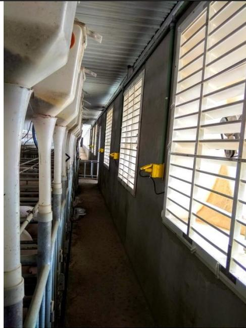
Contactos de motores 2 $\phi$  de extracción (instalación industrial IP67).
