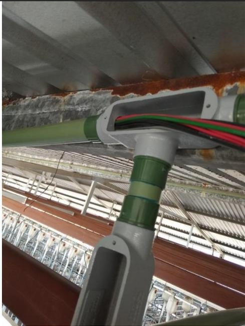
Cableado aparente (dentro de tubería PVC de 1").
