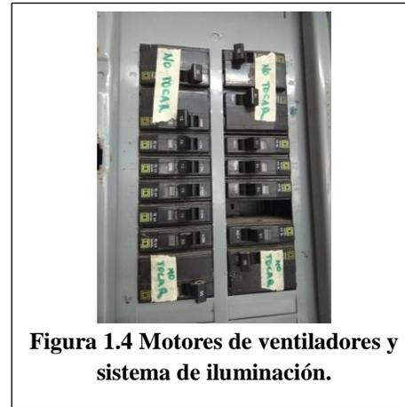
Se encuentra un sistema de control de ventilación, el cual detecta la temperatura actual por medio de un sensor tipo termopar y manda activar los ventiladores para estabilizar el ambiente en la sala. Su activación es manualmente con interruptores termomagneticos desde el centro de carga. Figura 1.5.
