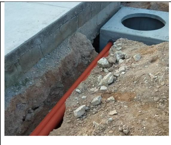
Posteriormente se llevó a cabo el cableado del conductor que viaja de los interruptores primarios a los interruptores secundarios de cada sala, con el número de calibre 1/0 de cobre y con tierra física calibre 6 desnudo de cobre. 4 conductores 1/0 (3 conductores de fase y 1 neutro) y 1 calibre 6 AWG para la tierra física en cada tubería de 3´´.
