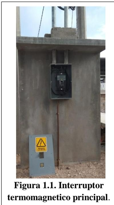
**Figura 1.1. Interruptor termomagnético principal.**
