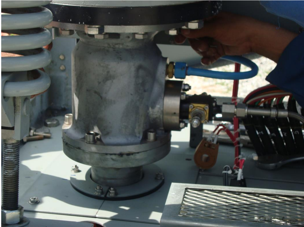
Cambio de electroválvulas
