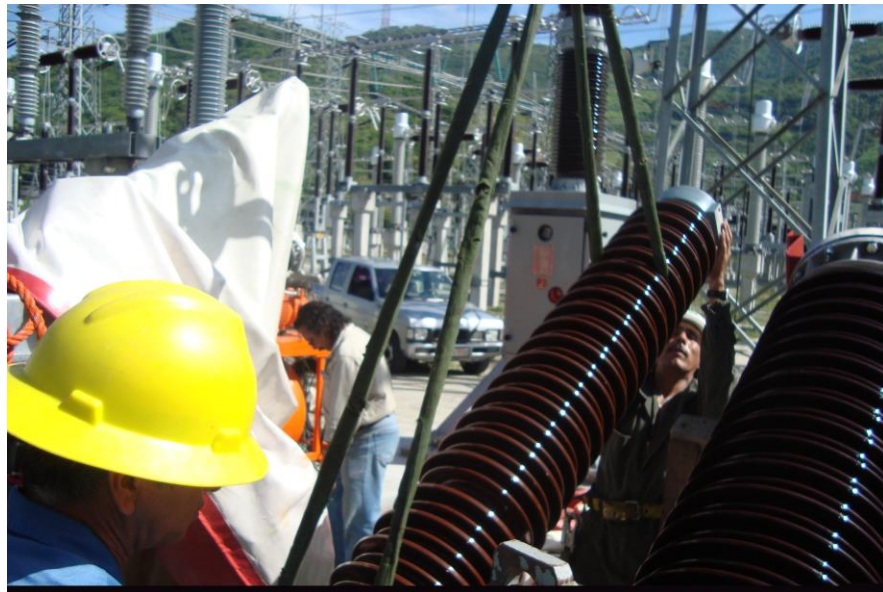
Montaje de los capacitores.
