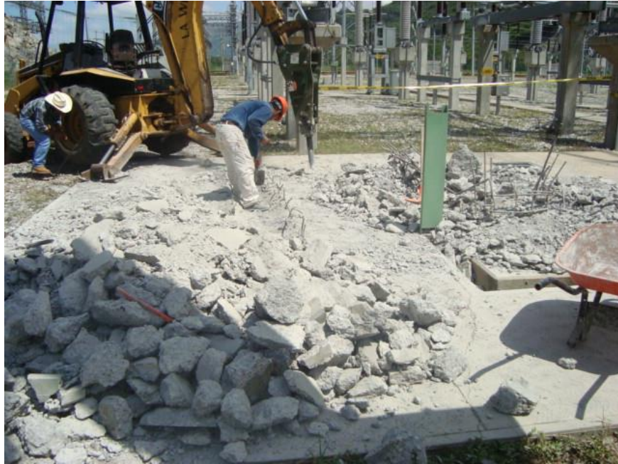
Una retroexcavadora poco a poco fue derribando los capiteles
