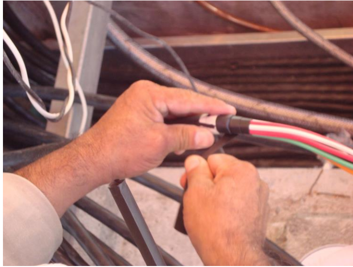
Colocación de cinta vulcanizable
