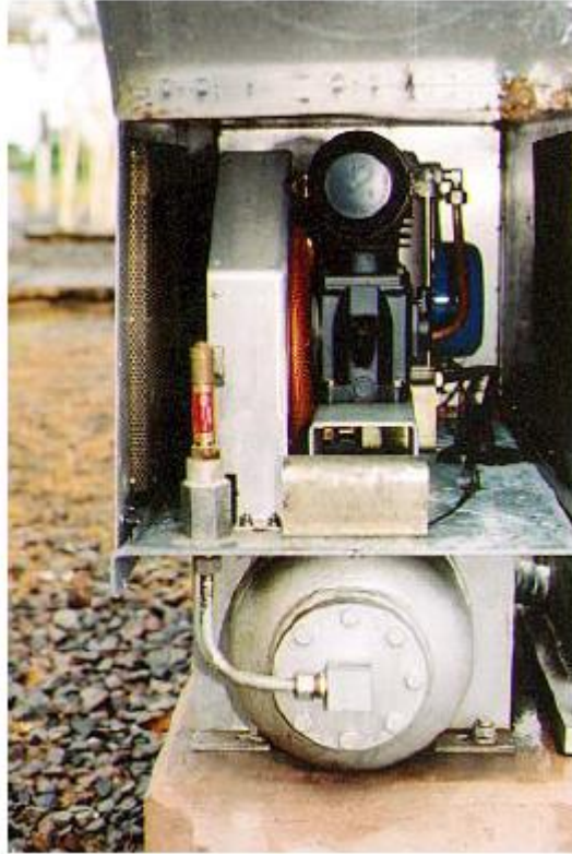
Mecanismo neumático para un interruptor de SF6, clase 125 kV.
