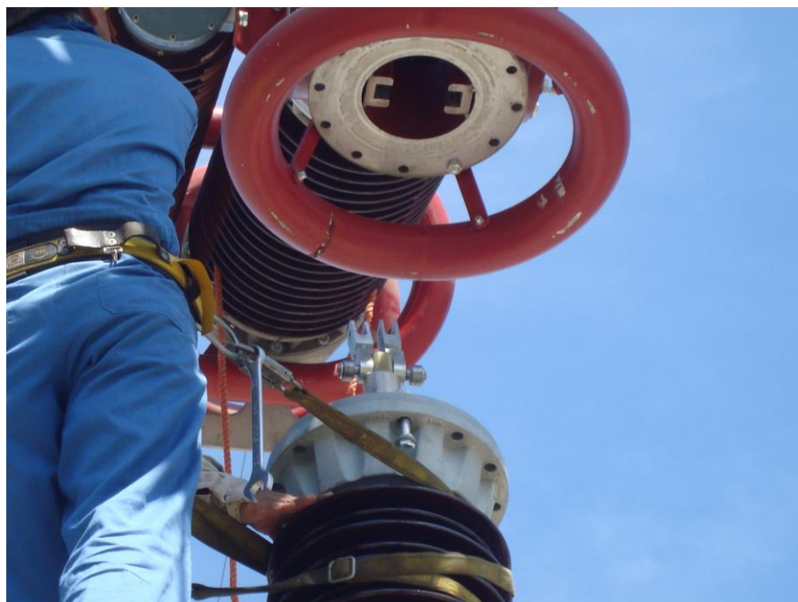
Montaje de cámara de extinción
