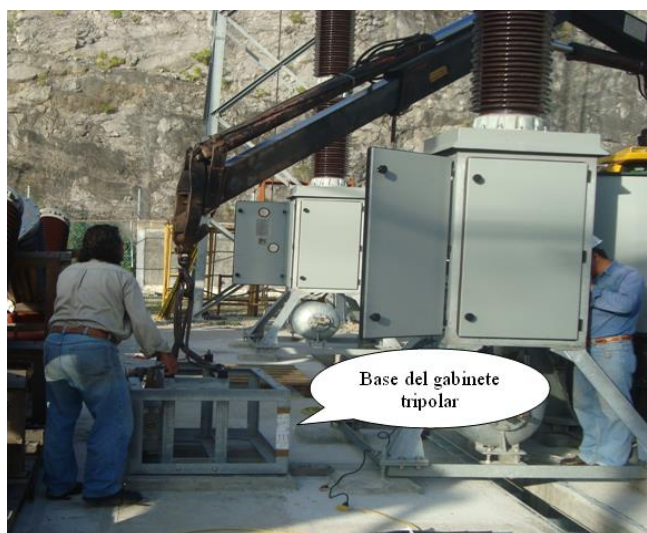
Instalación de la base para el gabinete tripolar.
