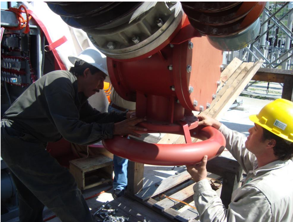
Montaje del aro equipotencial de la parte inferior de la cámara de extinción
