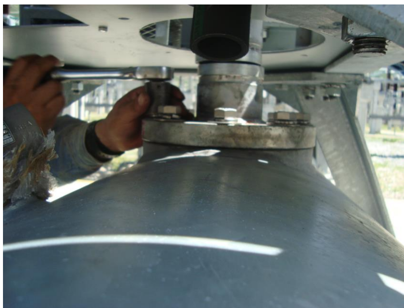
Instalación de tobera
