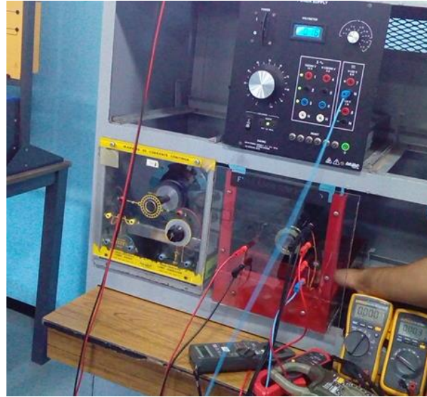
Figura 100 Realización de conexiones
