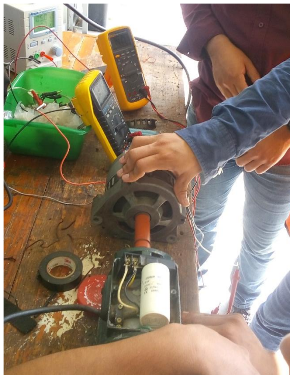
Figura 95 Acoplamiento directo de generador síncrono
