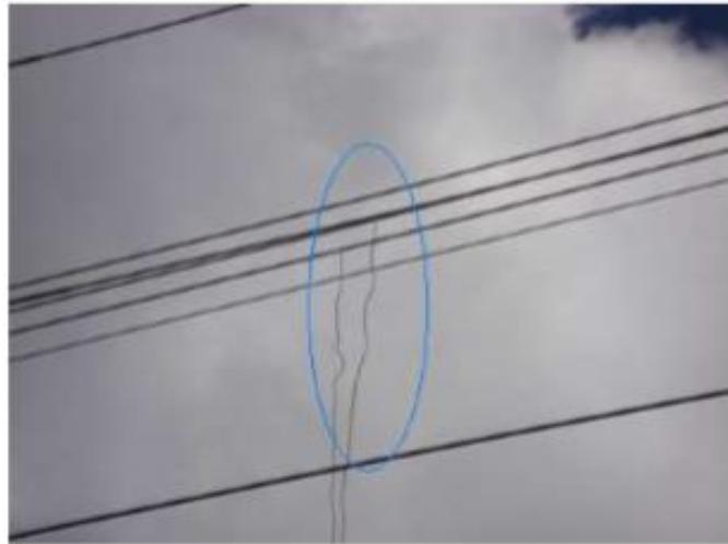
Ilustración 12 Conexiones ilegales
