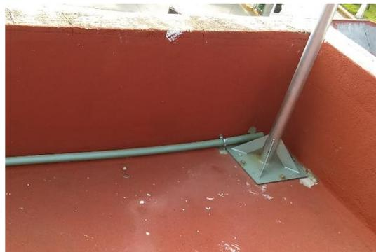
*Figura 4.2.- Base o mástil para el soporte del pararrayos.*
