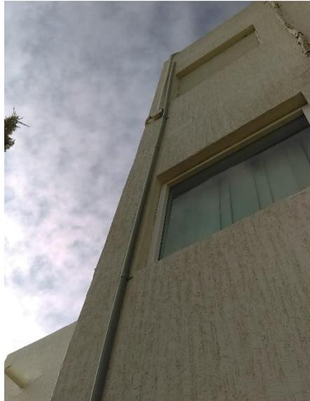
*Figura 4.3.- Bajada para el sistema de puesta a tierra.*
