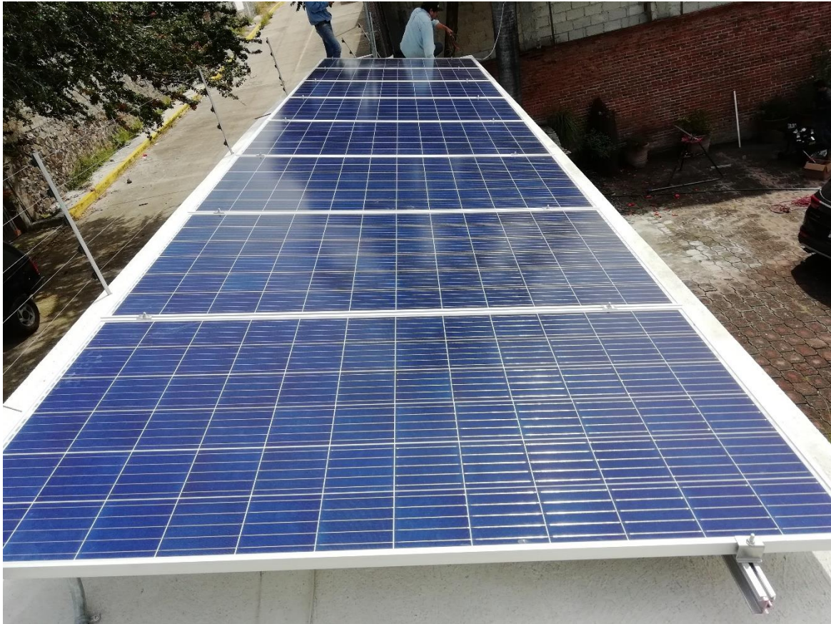
Instalación terminada junto a la estructura.
