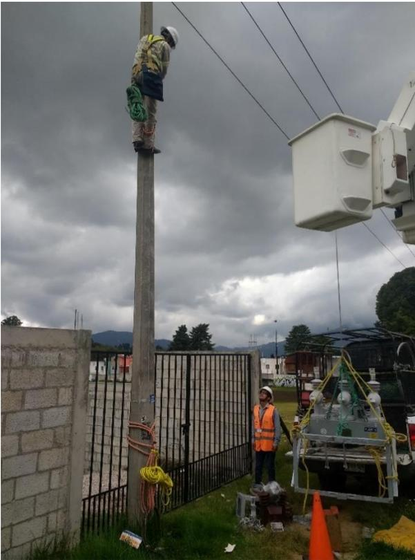
**Figura C - 1** Muestra el montaje del restaurador en una estructura TS30.
