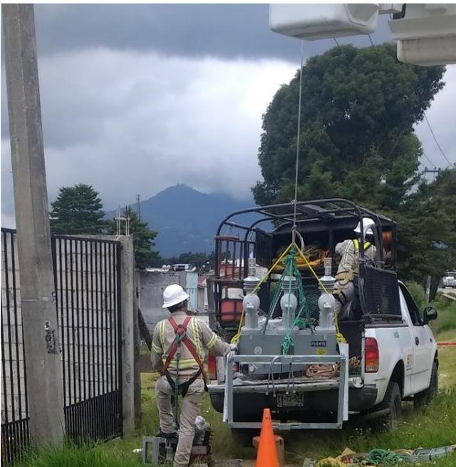
**Figura C - 2** Amarrar las cadenas o latiguillos con ganchos para el izado de cable.
