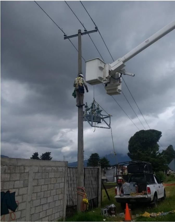
**Figura C - 3** Muestra el correcto Izado del restaurador.
