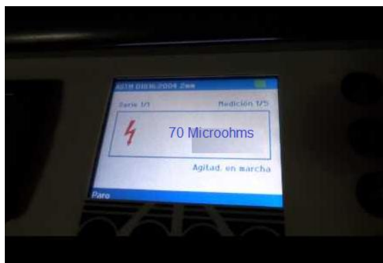
Figura 4.4 Prueba de Resistencia de Contactos del interruptor en vacío de 13.8 kV.
