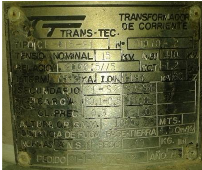
Figura 3.40 Datos de placa del TC tipo Pedestal de 13.8 Kv.
