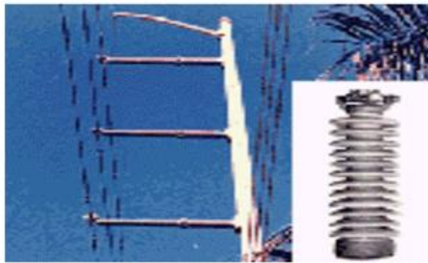
Fig. 3.12.2.3 Aislador tipo poste
